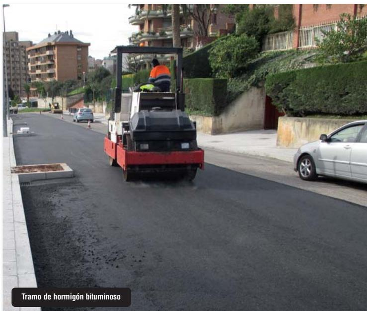
Tramo de hormigón bituminoso
