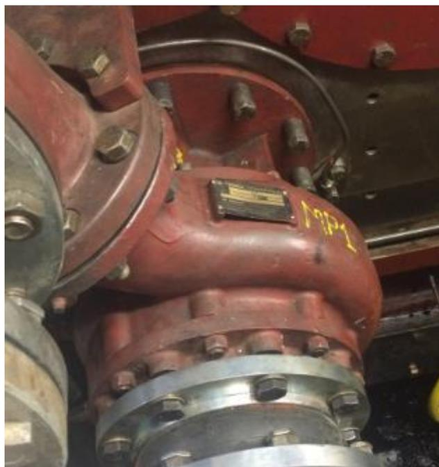
Imagen 33. Bomba de agua de refrigeración.
