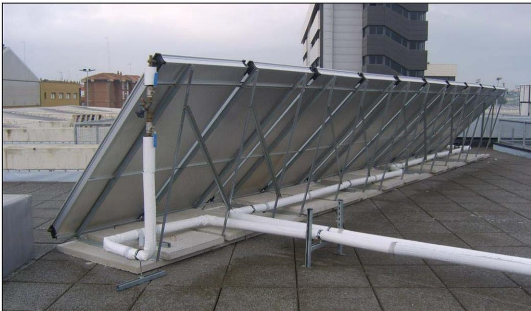
Fig. 23.- Estructura soporte en cubierta
