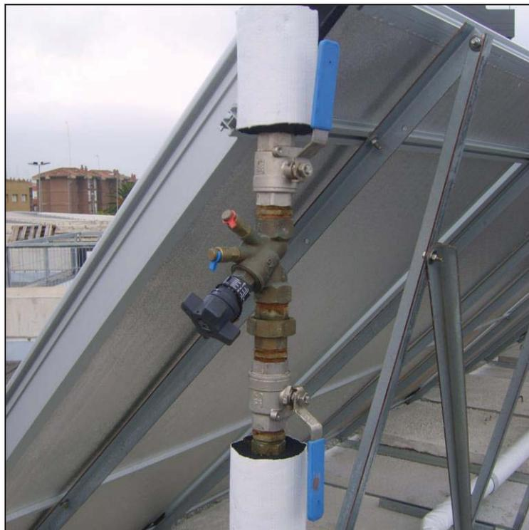
Fig. 27.- Válvula de compuerta y llave de paso
