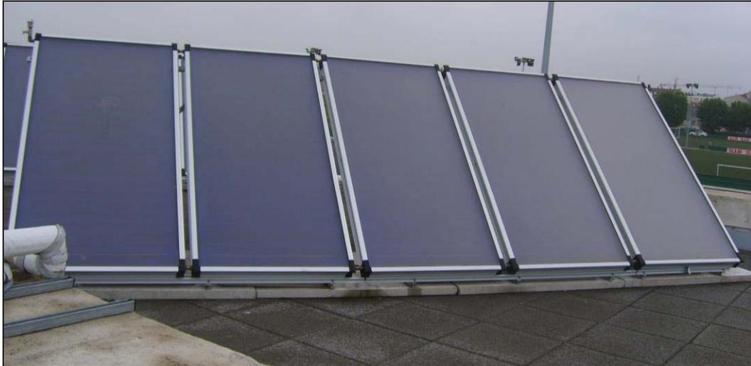
Fig. 22.- Captadores solares en serie
