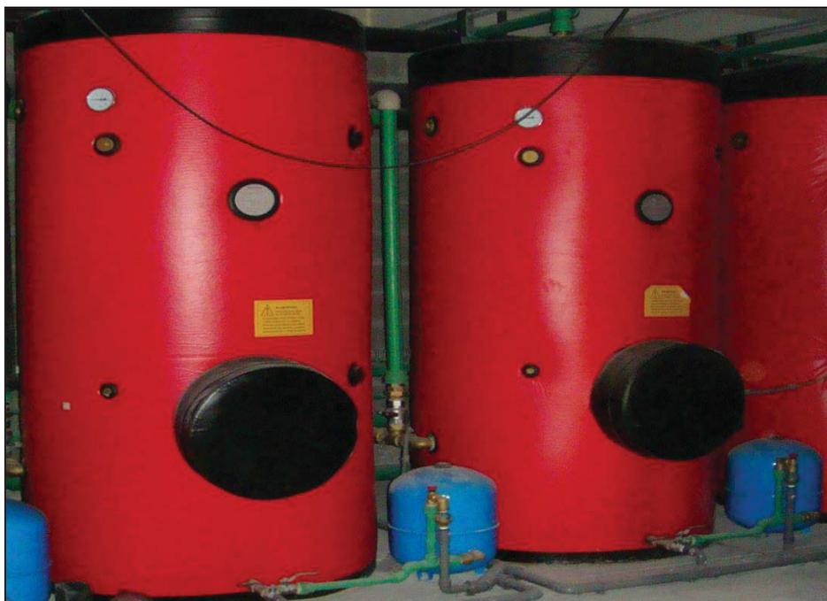
Fig. 28.- Depósitos interacumuladores con aislamiento. Vasos de expansión
