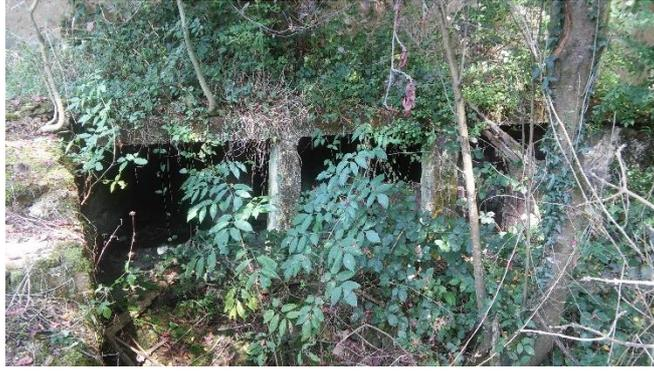
*Figura 19. Imagen de las aberturas en el edificio por donde entra el agua en el Molino de la Hoz.*
