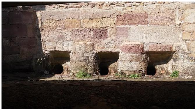
*Figura 14. Imagen de las aberturas por las que llega el agua del canal al del Molino del Puente.*
