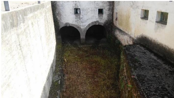
*Figura 21. Imagen de las entradas de agua de dos ojos de piedra del Molino de Cantera.*
