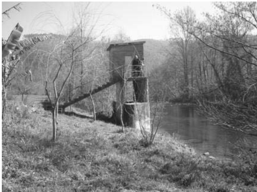
Figura 3-1: Estación de aforo Coterillo (río Asón)
