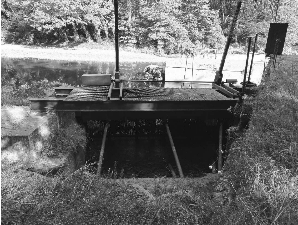
Figura 3-1: Vista interior de la toma de agua
