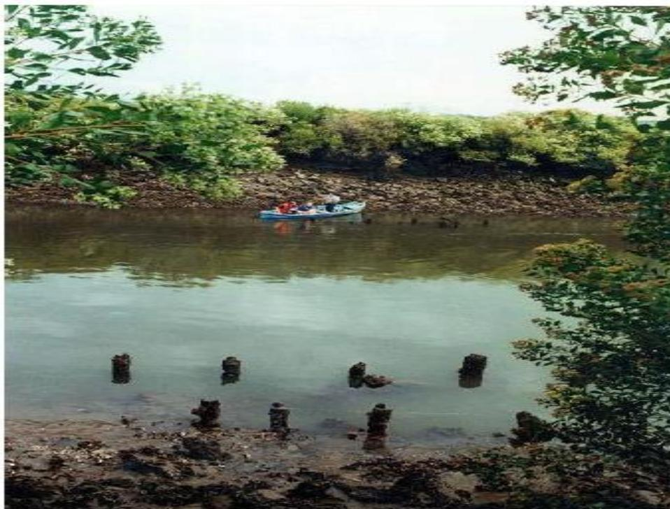
**Figura 4.2. Las cimentaciones de madera del puente sobre el Bidasoa. Foto: Arkeolan**
