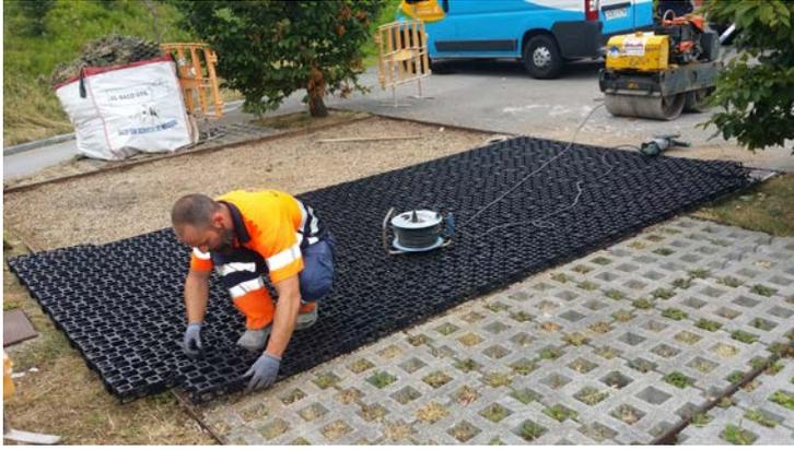
*Ilustración 49 Operario coloca celdas de plástico en plaza de aparcamiento*
