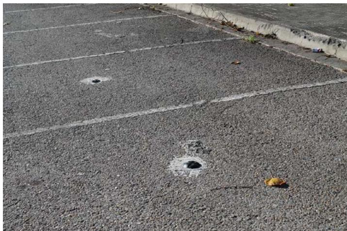
*Ilustración 34* Sensores de presencia de coche aparcado
