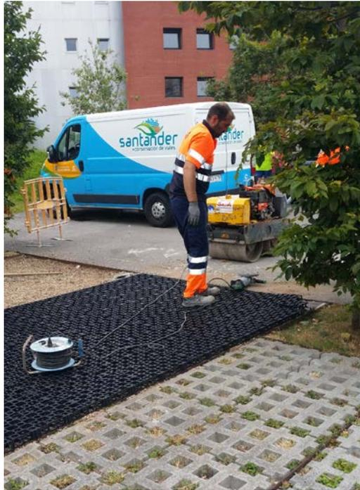
*Ilustración 50 Maquinaria utilizada: apisonadora y rotaflex*
