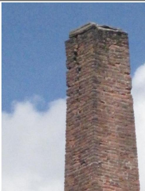
Foto 3: Fisura vertical en el remate en la cara oeste de la chimenea
