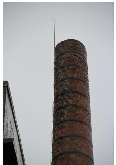
Foto 9: Procesos patológicos agravados en la parte superior de la chimenea
