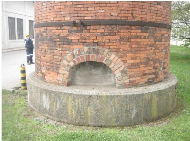
Fig 2.2: Plataforma maciza de hormigón
