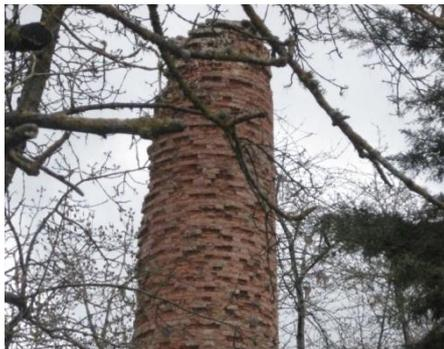
Foto 4: Procesos severos de desagregación
