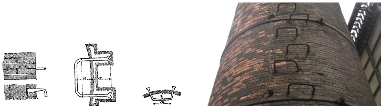
Fig 2.10 Elementos de ascensión instalados en las chimeneas.
