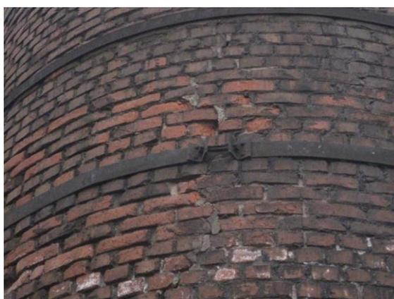
Fig 4.4: Fisura tratada en la chimenea Gran Forja (CHIM\_N11). Se aprecia la plastificación del zuncho coincidiendo con la fisura
