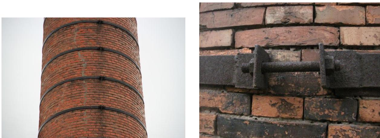
Fig 2.11: Zunchado de las chimeneas
