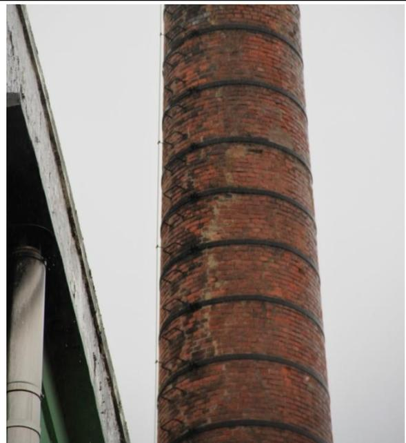
Foto 2: Fisura tratada causada, aparentemente, por tracciones térmicas
