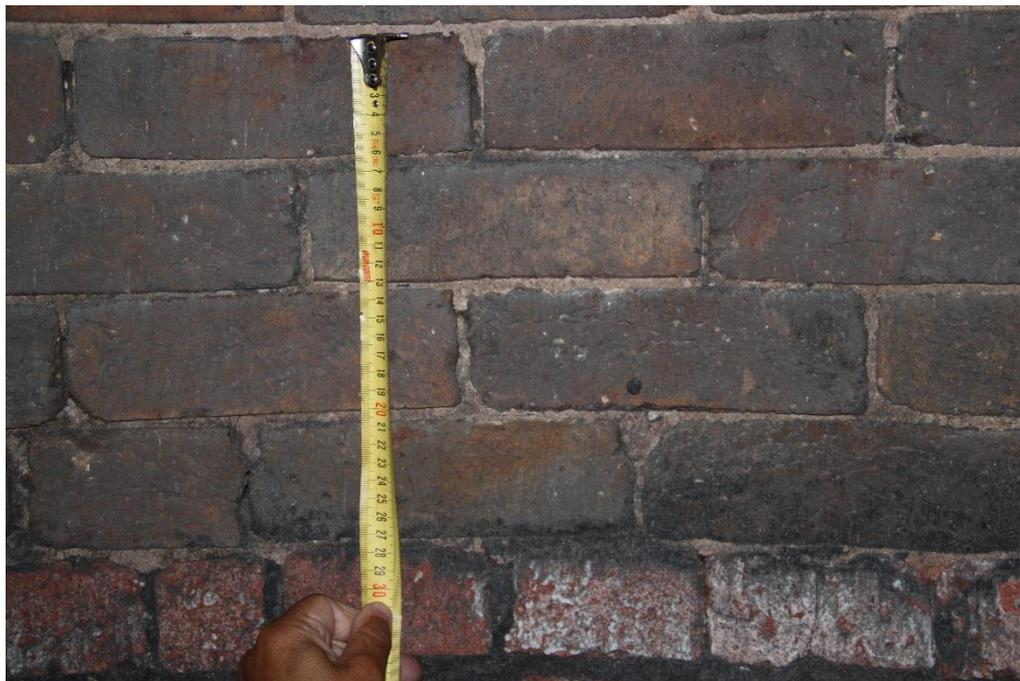
Fig. 5.20: Relación entre el alto de la pieza y el espesor de los tendeles.
