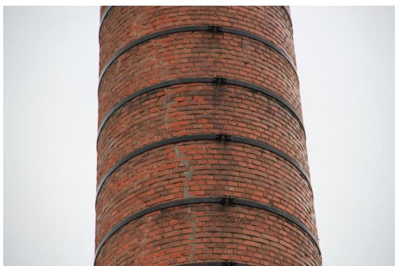
Fig 5.5: Aparejo constructivo y tratamiento de agrietamientos verticales
