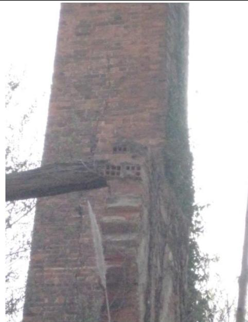
Foto 2: Grieta vertical en la cara este de la chimenea
