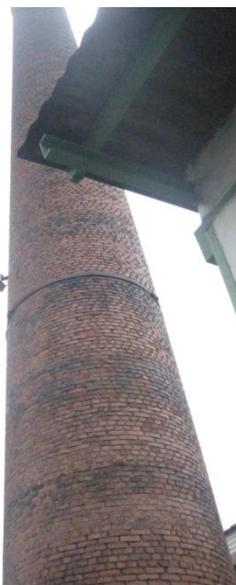
Foto 4: Zuncho metálico y foco de iluminación
