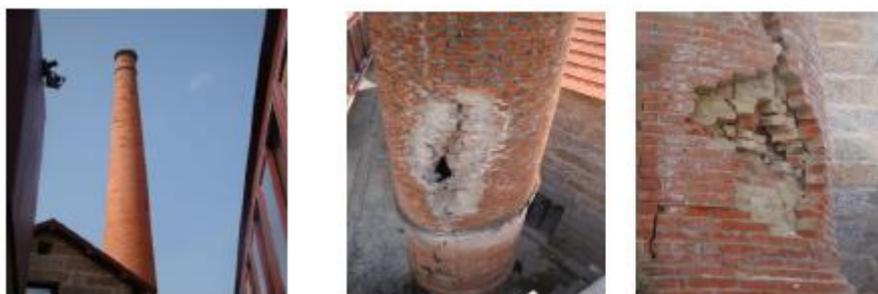
Fig 2.12: Chimenea caso de estudio y aberturas ocasionadas por una descarga eléctrica
