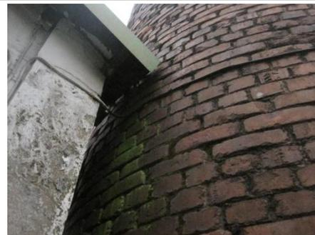
Foto 3: Pátina biogénica por efecto del agua descendente de canalón
