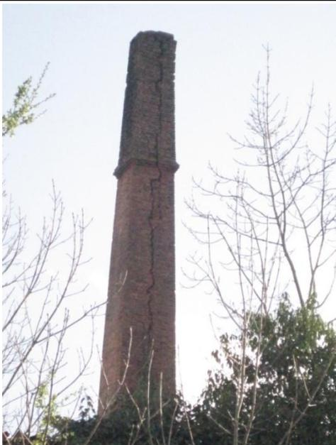
Foto 1: Fisura vertical en la cara norte de la chimenea
