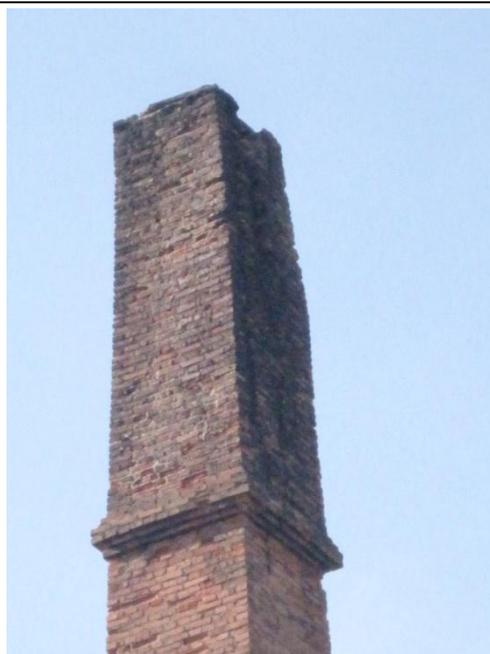
Foto 4: Fisuras en la cara este del remate
