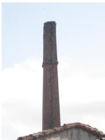
Fig 4.3: Grieta en la fachada norte de la chimenea en Sarón (CHIM\_N3)
