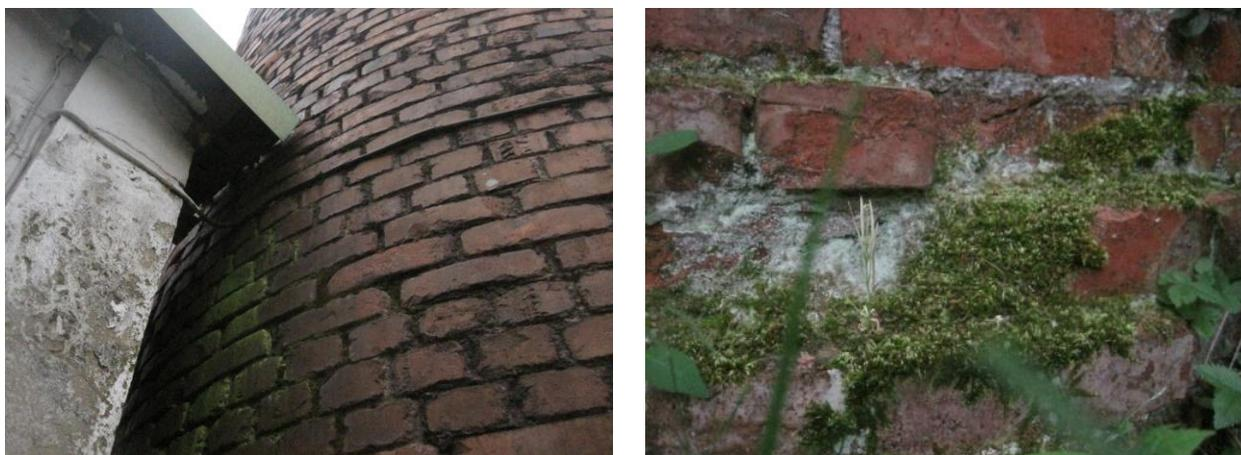
Fig 4.5: Alteraciones en el color de la fábrica. Acumulación de agua y humedad por la cercanía al canalón
