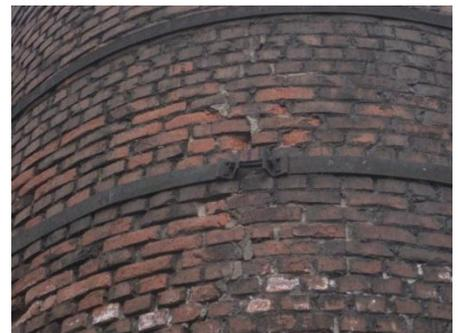
Foto 6: Plastificación del anclaje por apertura de fisura
