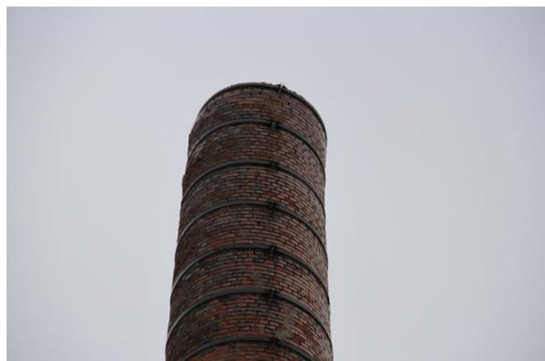
Fig 5.4: Desplome del coronamiento de la chimenea
