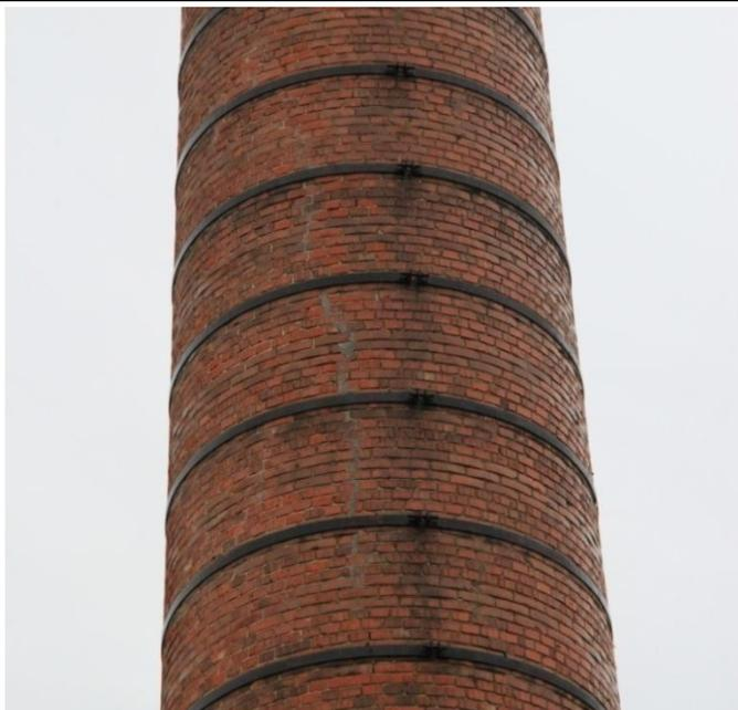
Foto 1: Fisura tratada causada, aparentemente, por tracciones térmicas
