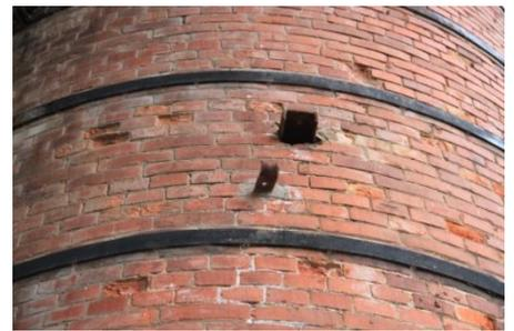
Foto 6: Anclajes y desagregación
