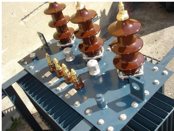
Figura 2.4 Pasantes de un transformador
