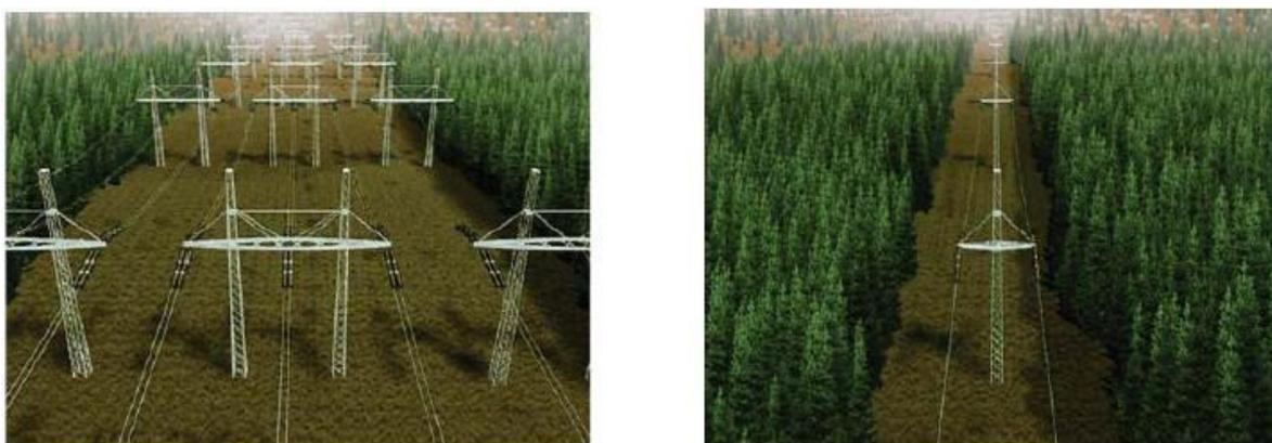
*Franja de servidumbre para el caso 500 KV HVAC y  $\pm 500$  HVDC para transportar 3000 MW*
