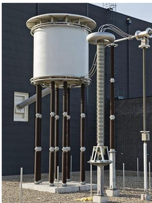
Figura 18. Smoothing Reactor de aire de Siemens.
