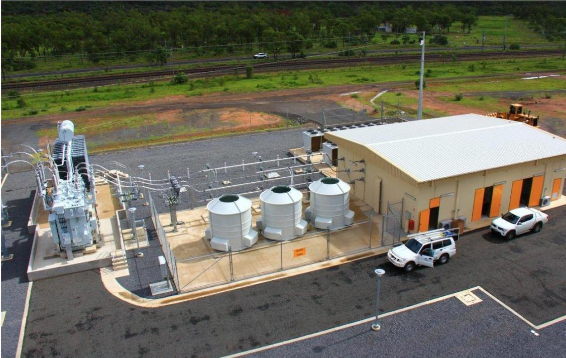
Figura 22. Construcción de una instalación 132kV *Static Var Compensator* (SVC) [49]
