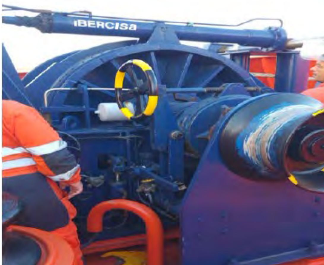
Ilustración 76: Maquinilla hidráulica de proa.
