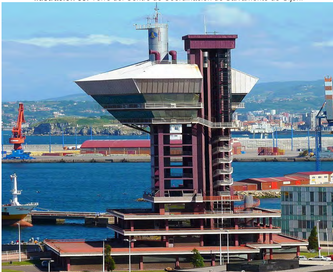
Ilustración 38: Torre del Centro de Coordinación de Salvamento de Gijón.
