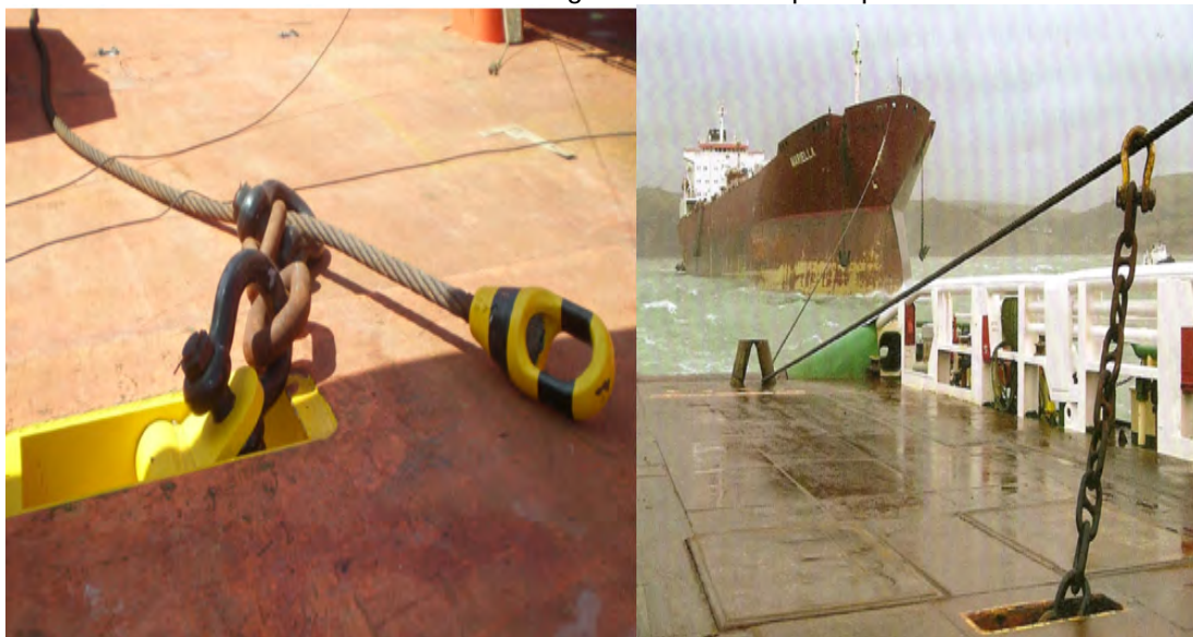
Ilustración 86: Arraigado en cubierta principal.
