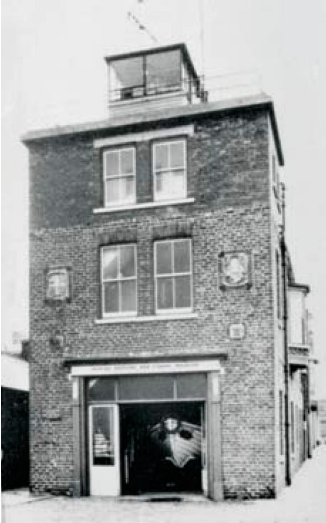
Ilustración 18: Estación del RNLI
