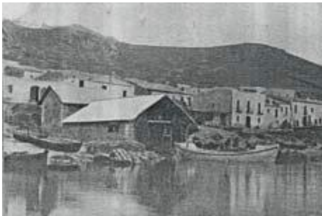
Ilustración 22: Caseta del SESN con bote salvavidas en Port de la Selva
