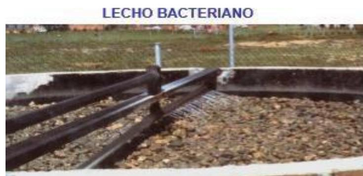
Figura 1. Imagen que ilustra el medio filtrante de un lecho bacteriano
