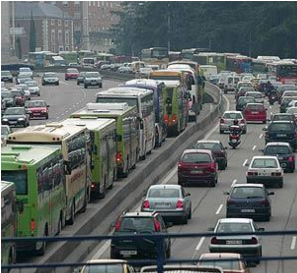
Ilustración 13: Carril bus con separadores de hormigón
