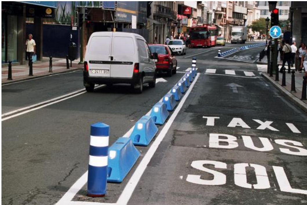
Ilustración 14: Carril bus con separadores plásticos
