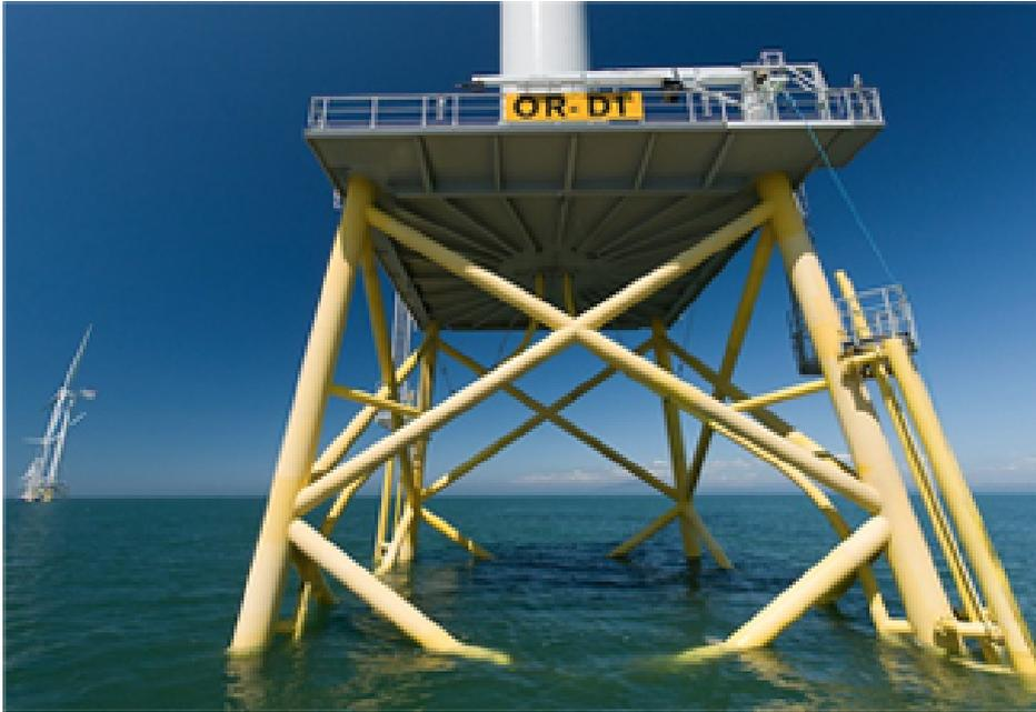
Figura 2.27: OWEC Quattropodó. [Fuente: OWEC]
