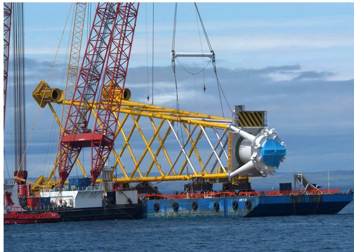
Figura 2.25: Jacket utilizado en Beatrice Demonstrator Project, con las guías para el pilotaje en la base. [Fuente: BIFAB]
