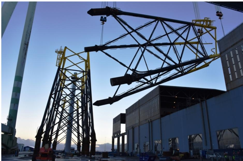
Figura 2.30: Jacket utilizado en Wikinger. [Fuente: BLADT Industries]
