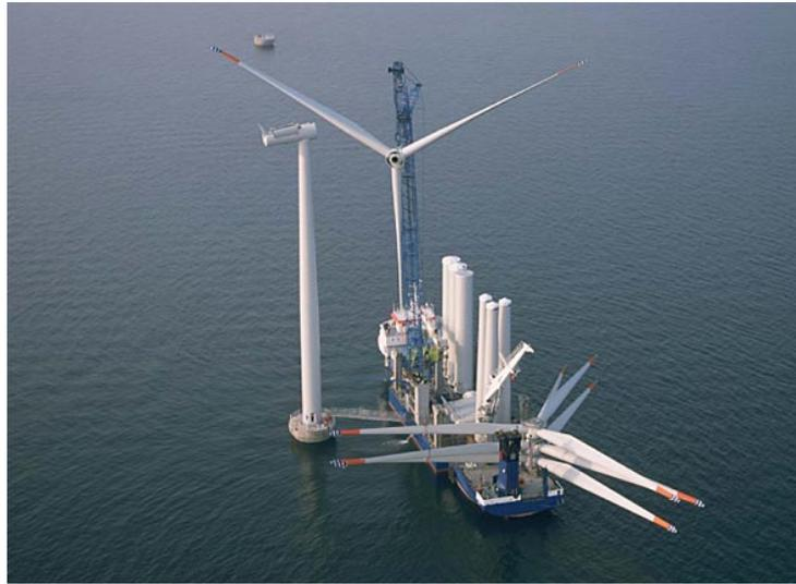
Figura 2.10: Construcción de la primera turbina en Nysted Offshore Wind Farm. [Fuente: Danish Energy Authority]
