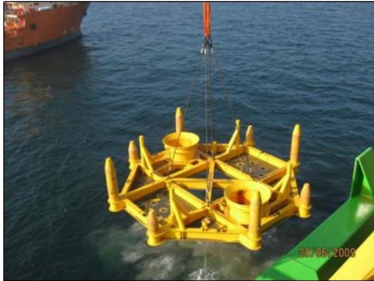
Figura 2.22: Plantilla utilizada en Alpha Ventus. [Fuente: 4COffshore]
