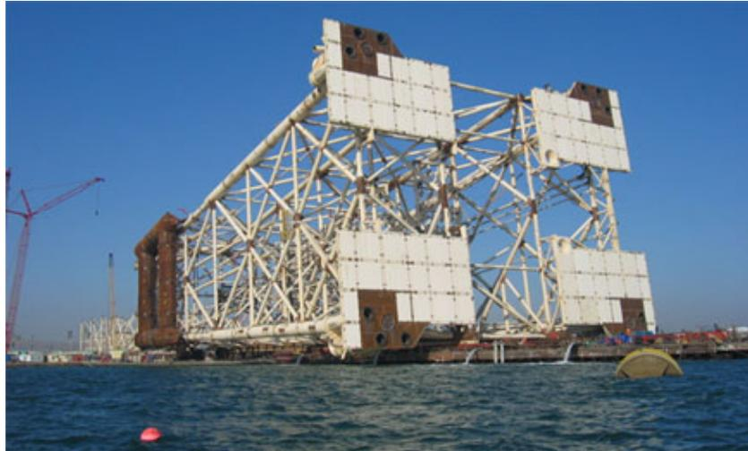
Figura 2.24: Paneles de geotextil en la base del jacket. [Fuente: Tension Technology International]
