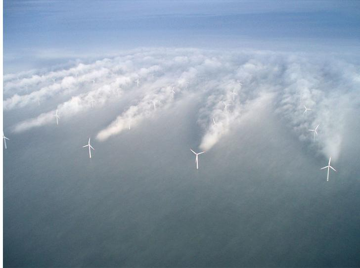
Figura 2.11: Turbulencias generadas por las turbinas en el parque eólico de Horns Rev, Dinamarca. [Fuente: Vattenfall Wind Power]
