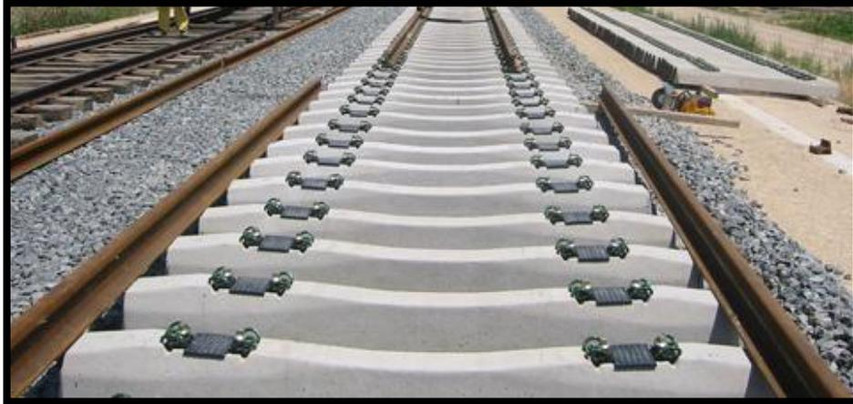
Figura 22. Traviesas monobloque de hormigón
