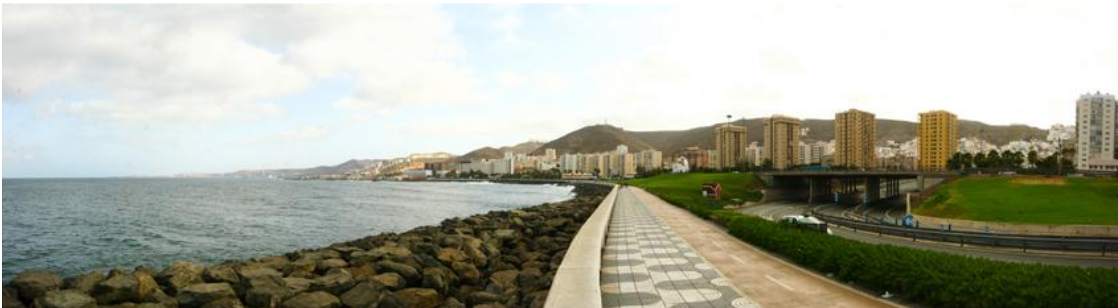
2.2, 2.3, Vista al Sur (arriba) y al Norte (abajo) desde el enlace en el que saldrá nuestro dique.
