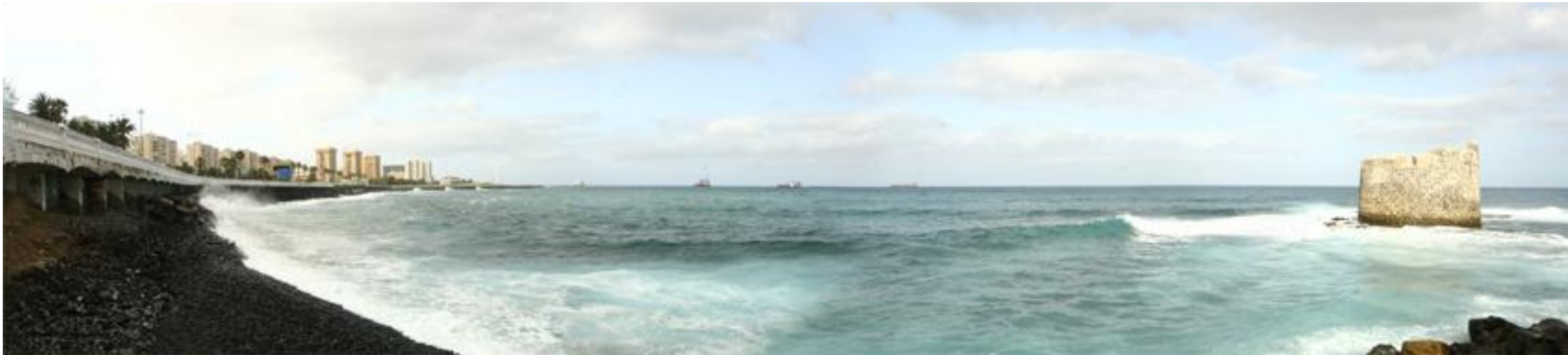
2.1 Vista al Norte desde la playa de gravas. Se observa con claridad como esta playa no es apta para su uso.
