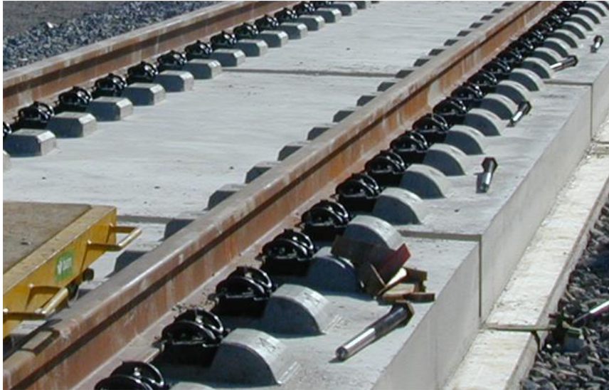
Figura 3: Ejemplo de vía en placa https://upload.wikimedia.org/wikipedia/commons/3/36/RHEDA_2000_-_10.JPG
