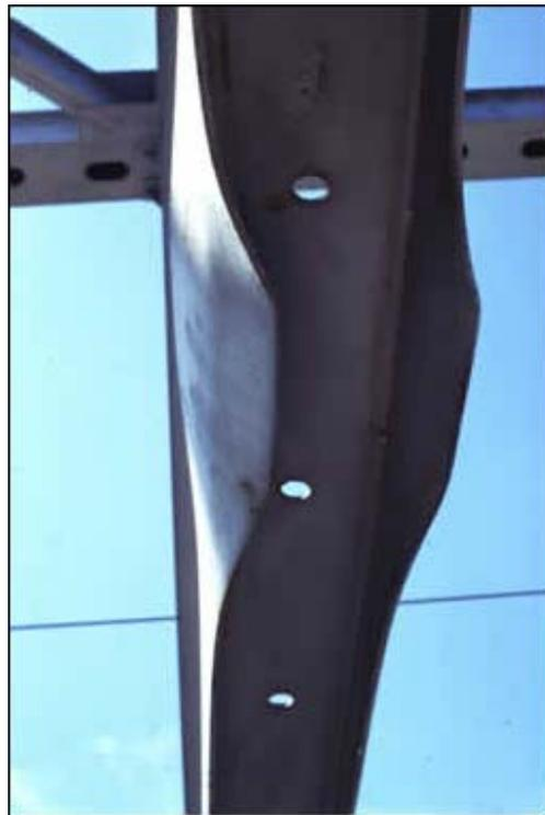
*Figura 2.7 Daño de tipo L en una vigueta. Las almas han sufrido un aplastamiento debido al golpeo de una carga [1]*
