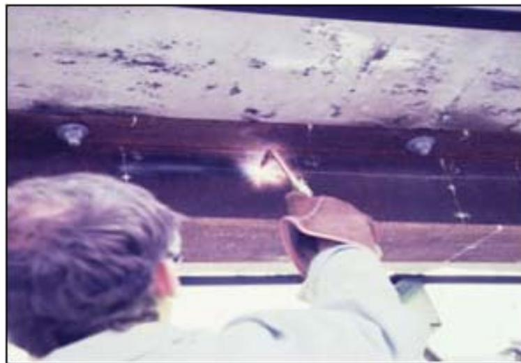
*Figura 2.10 Patrón lineal de calentamiento sobre un perfil metálico. [1]*
