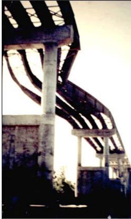
*Figura 2.4 Daño de tipo W en las vigas principales de un puente en su fase constructiva*
