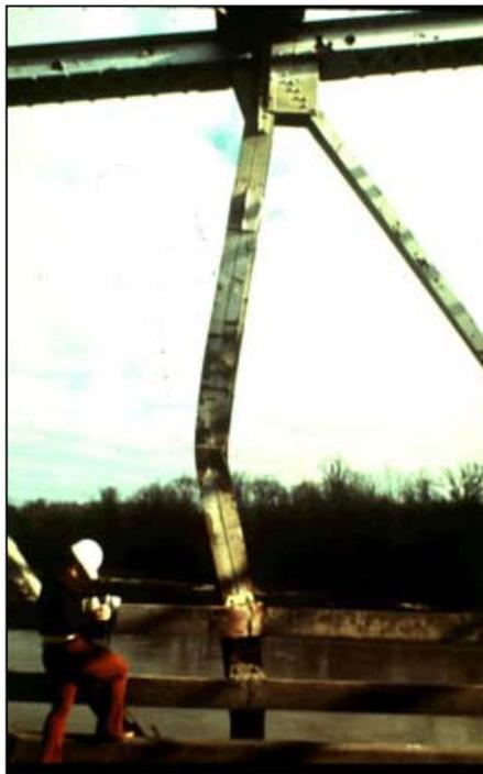
**Figura 2.3** Daño de tipo *W* en el tirante de un puente metálico debido a la caída de la carga de un camión en EEUU. [1]
