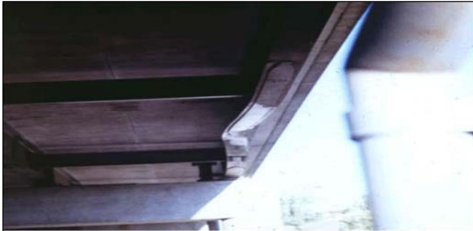
*Figura 2.6 Daño tipo T en una viga de un puente en uso. El daño se produjo por el impacto de un vehículo pesado. [1]*
