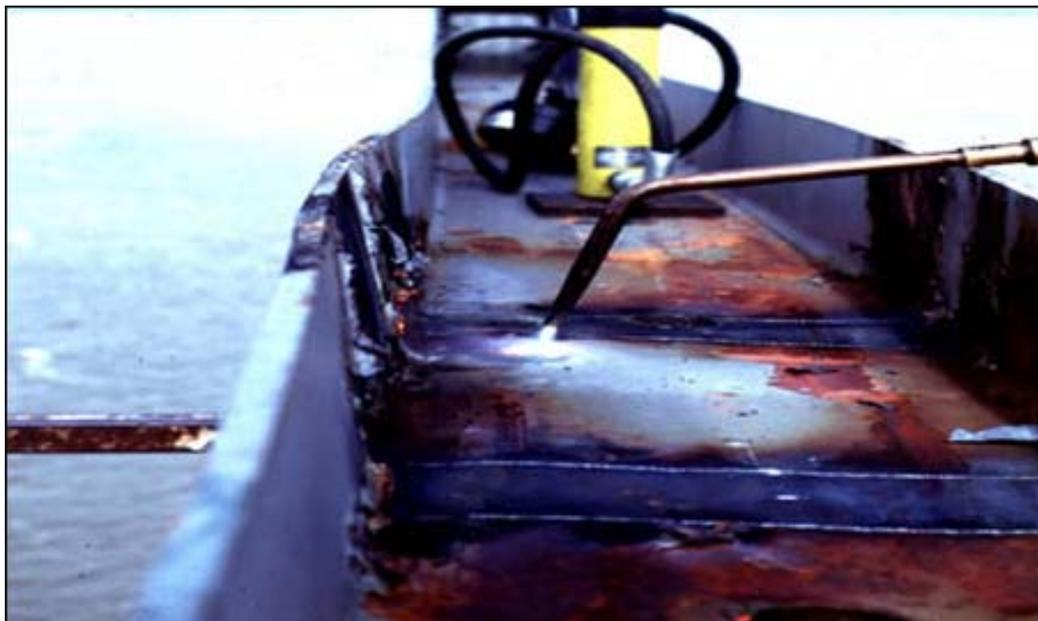
*Figura 2.15 Ejemplo del patrón de calentamiento en bandas sobre un perfil metálico.[1]*
