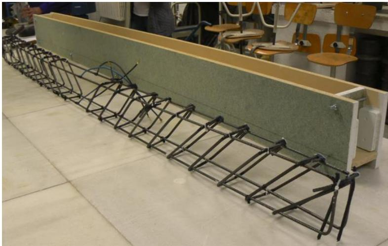
**Figura 42.** Armadura de la viga formada por barras longitudinales y estribos.
