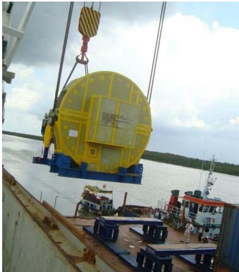
Ilustración 75 - Posicionamiento de la turbina sobre soporte soldado en gabarra. Fuente: Marmedsa proyectos.
