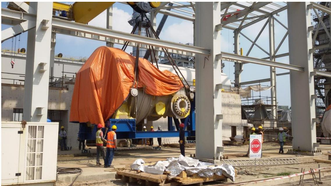
Ilustración 86 - Turbina ya soportada por las grúas de la central para su correspondiente instalación y retirado el SPMT. Fuente: Marmedsa proyectos.
