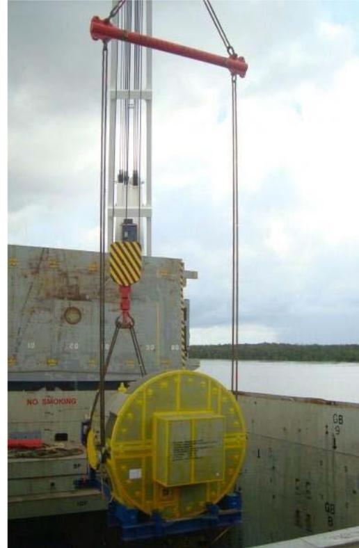
**Ilustración 73 - Descarga de la turbina desde bodega de buque hasta gabarra. Fuente: Marmesa proyectos.**
