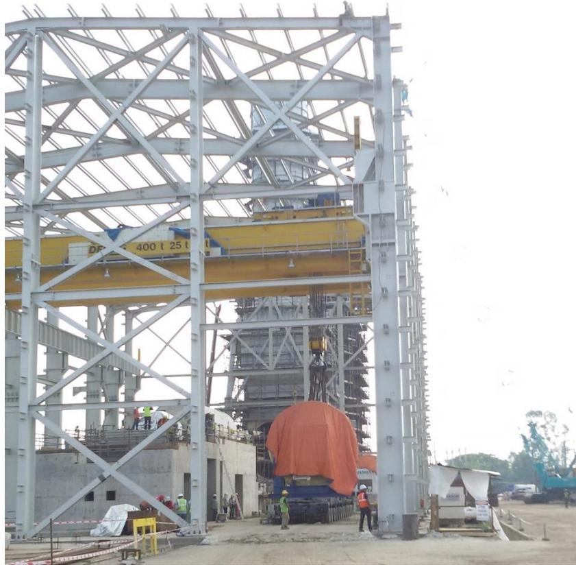
Ilustración 85 - Posicionado en la central de la turbina sobre el SPMT. Fuente: Marmedsa proyectos.
