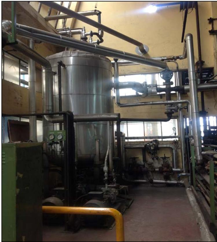
Ilustración 10 - Desgasificador planta Bridgestone. (Fuente: Elaboración propia)
