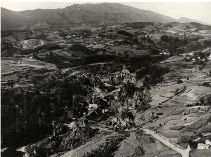
denominada *Corta* o *Zanjón*. La extracción del mineral de esta zona, se realizó mediante una serie de bancos y rampas, siguiendo la pendiente del terreno. <sup>46</sup>
