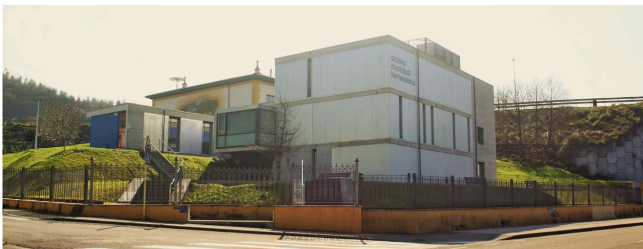
Vista exterior del edificio (02)
