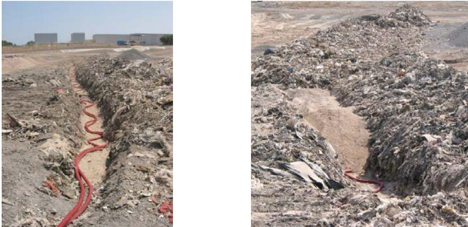
**Imagen 3-4. Extensión de cables y mangueras (izq.) tapado con arena y residuo(dcha.)**
