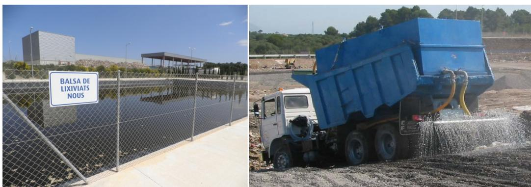
**Imagen 3-2. Balsa de acumulación de lixiviado (izq.) y camión recirculando lixiviado (dcha.)**
