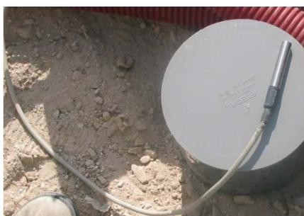
Imagen 3-10. Termómetro PT100 instalado en el vertedero
