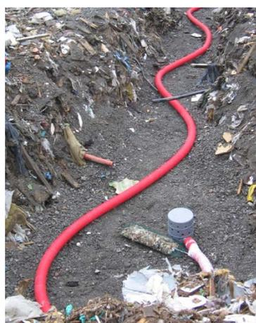
Imagen 3-7. Detalle de tomamuestras y disposición en vertedero
