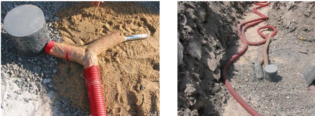
**Imagen 3-5. Colocación de un piezómetro y tomamuestras (izq.) y una termorresistencia y tomamuestras (dcha.)**
