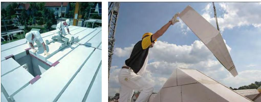
Las placas de cubierta están destinadas a la construcción de cubiertas inclinadas o cubiertas planas, hasta luces de aproximadamente 6m y sobrecargas habituales. Nuestro diseño da luces de 5 metros, con lo que cumple ese requisito.
