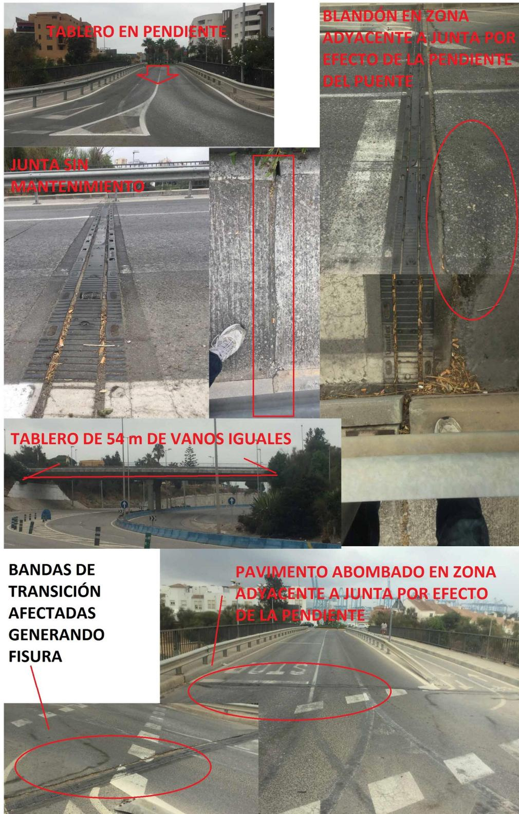
Fig. 4.1. 20: Estado de juntas en puente urbano de vigas de dos vanos y 54 m de longitud en Algeciras
