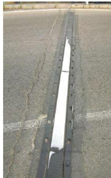
**Fig. 4.1. 10: Patología por envejecimiento del elastómero del perfil armado de junta.(ATC [Asociación Técnica de Carreteras], 2003, pág. 95)**
