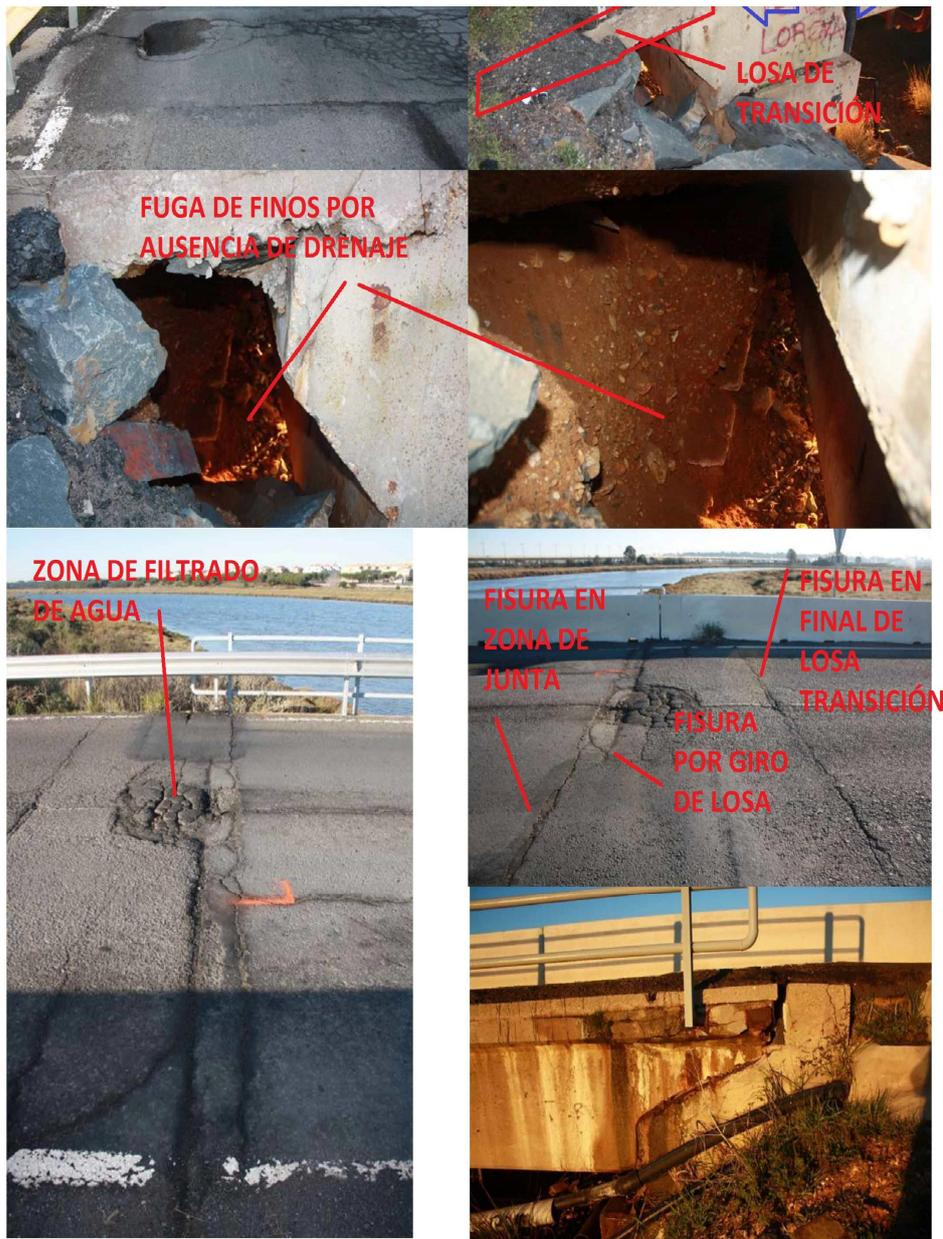
**Fig. 4.1. 1:** Puente real a rehabilitar con ausencia de junta, y apoyos en mal estado. Los ciclos térmicos, y sobre todo, la erosión del agua han arruinado el estribo del puente. Cortesía de Azul de revestimientos andaluces S.A.
