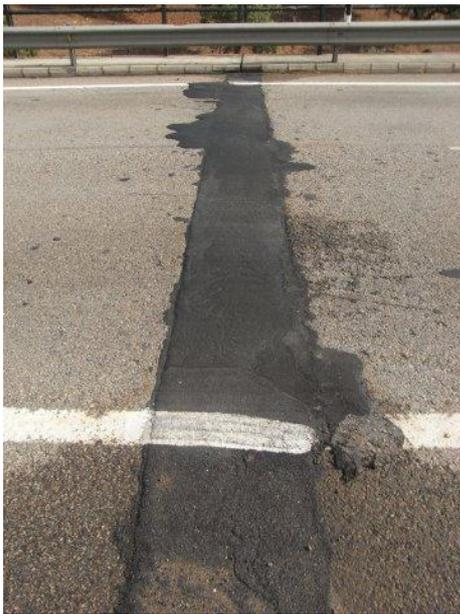
*Fig. 4.1. 16: Junta cegada provisionalmente. Cortesía de AZUL*
