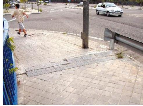
*Fig. 4.1. 5: Patología por ausencia de junta en zona de aceras.(ATC [Asociación Técnica de Carreteras], 2003, pág. 94)*
