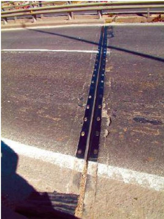
*Fig. 4.1. 4: Patología por aterramiento de junta. Los morteros de acompañamiento no han tenido un correcto puente de unión con el pavimento por lo que se han convertido en vías de entrada de agua. (ATC [Asociación Técnica de Carreteras], 2003, pág. 93)*
