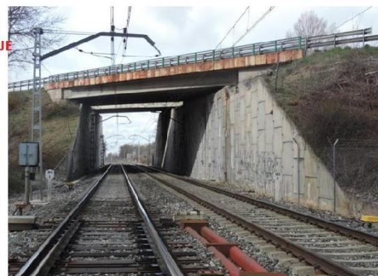
*Fig. 2.5. 11: Estribo flotante.(Arenas & Aparicio, 1984). Y patologías en flejes por filtraciones de agua con salmuera a través de la junta (Cortesía de D. Carlos Alonso Cobo)*
