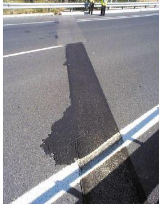
**Fig. 4.1. 13:** Patología por deterioro del betún modificado de la junta.(ATC [Asociación Técnica de Carreteras], 2003, pág. 96)
