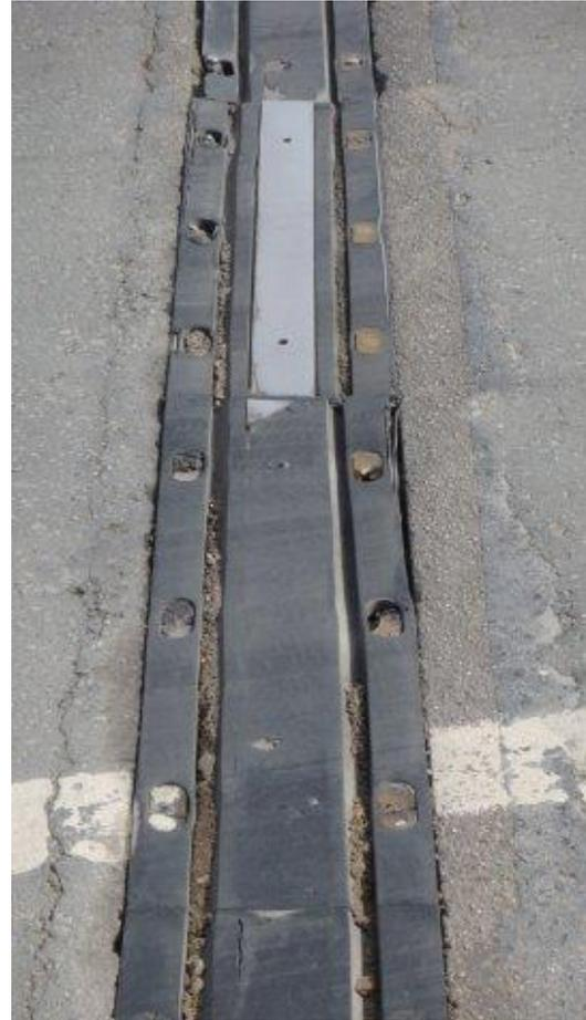
*Fig. 4.1. 17: Junta de elastómero armado sin mantenimiento de limpieza y con pérdida de pernos. Cortesía de AZUL de REVESTIMIENTOS S.A.*
