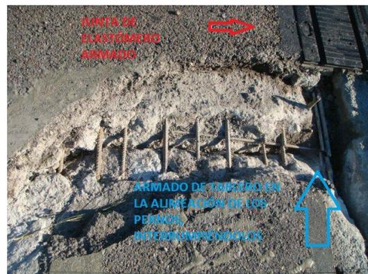
*Fig. 4.1. 18: Junta de elastómero armado; alineación de pernos interfiriendo con el armado. Cortesía de AZUL de REVESTIMIENTOS S.A.*
