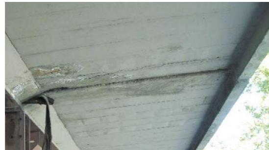
**Fig. 4.1. 14:** Patología por rotura y hundimiento de junta en voladizo de puente.(ATC [Asociación Técnica de Carreteras], 2003, pág. 96)
