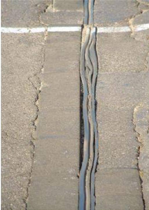
**Fig. 4.1. 11:** Patología por envejecimiento del perfil de caucho comprimido.(ATC [Asociación Técnica de Carreteras], 2003, pág. 96)
