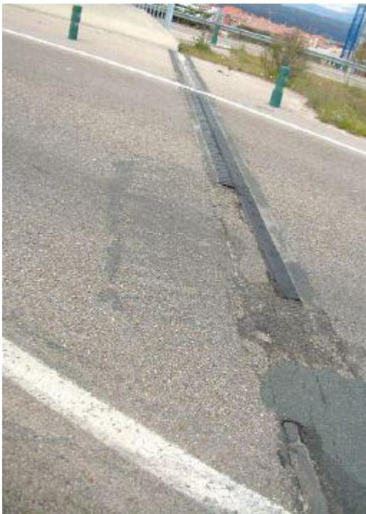
**Fig. 4.1. 12:** reparación incorrecta sobre junta.(ATC [Asociación Técnica de Carreteras], 2003, pág. 96)
