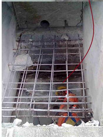
**VIGA RIGIDIZADORA DEMOLIDA PARA LA ELIMINACIÓN DE JUNTA DE CALZADA ENTRE VANOS DE VIGAS PREFABRICADAS. ESTA VIGA-DIAFRAGMA RIGIDIZA AMBOS LADOS DE JUNTA. SIMÉTRICAMENTE A PLANO TRANSVERSAL POR EJE DE PILA EXISTÍA VIGA-DIAFRAGMA SIMÉTRICA**
