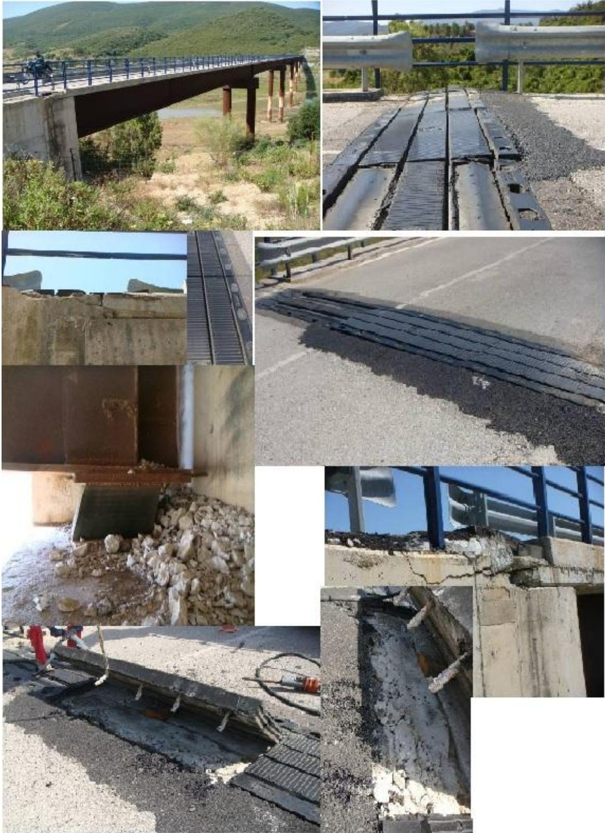
*Fig. 4.1. 21: Estado de junta de elastómero armado en que se ha desprendido un módulo. Cortesía de Azul de revestimientos andaluces S.A.*
