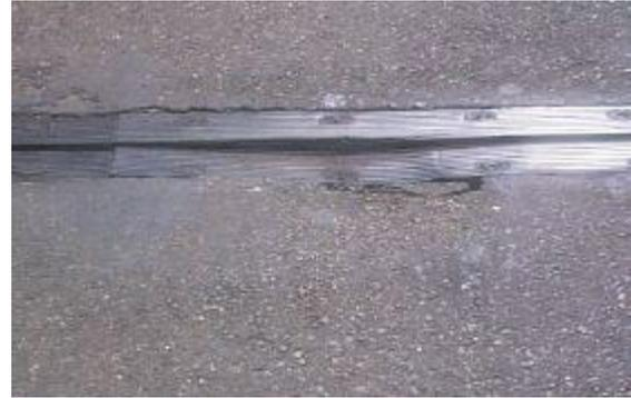
**Fig. 4.1. 9: Patología por hundimiento de morteros de junta. La causa es una instalación inadecuada.(ATC [Asociación Técnica de Carreteras], 2003, pág. 95)**
