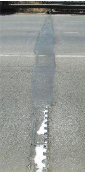
**Fig. 4.1. 8: Patología por pavimentación sobre junta. A la mínima variación térmica se vuelve a manifestar la junta, volviendo a ser vía de filtración de agua. (ATC [Asociación Técnica de Carreteras], 2003, pág. 95)**
