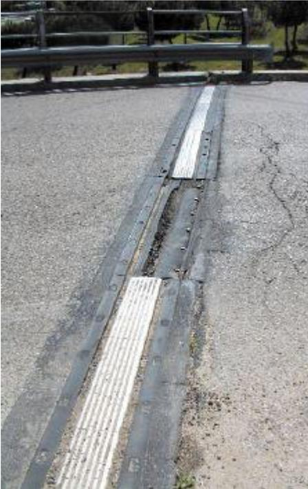
**Fig. 4.1. 7: Patología por falta de mantenimiento. La pérdida de las placas deslizantes pueden causar grave daño al usuario, lo mismo que las cabezas de los pernos remanentes, (ATC [Asociación Técnica de Carreteras], 2003, pág. 94)**
