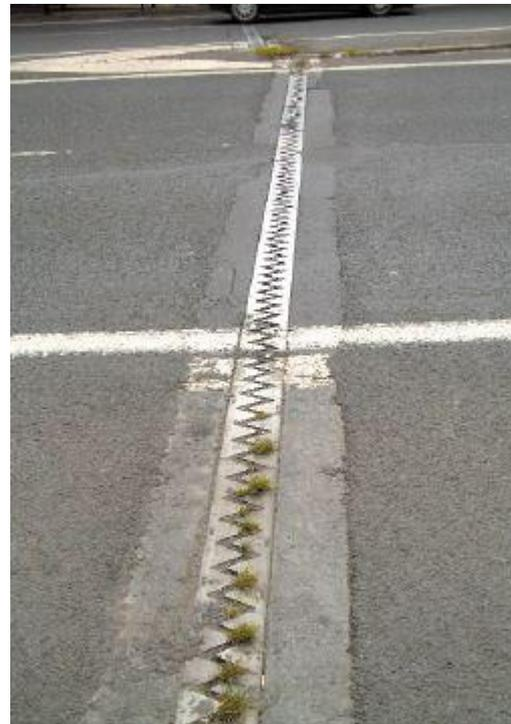
*Fig. 4.1. 6: Patología por aterramiento y falta de mantenimiento.(ATC [Asociación Técnica de Carreteras], 2003, pág. 94)*
