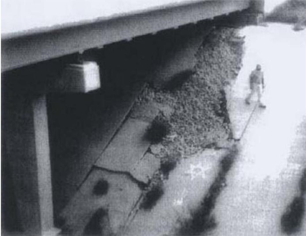
*Fig.4.2. 12: Patologías asociadas al agua en estribos: erosión en talud. (Long, Olson, Stark, & Samara, 1998)*
