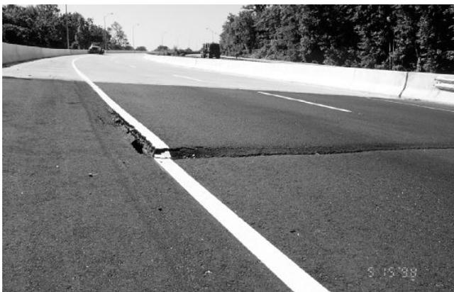
*Fig.4.2. 22: Efecto de losa de aproximación peraltada por efecto del asiento por consolidación del terraplén.(Hoppe, 1999)*
