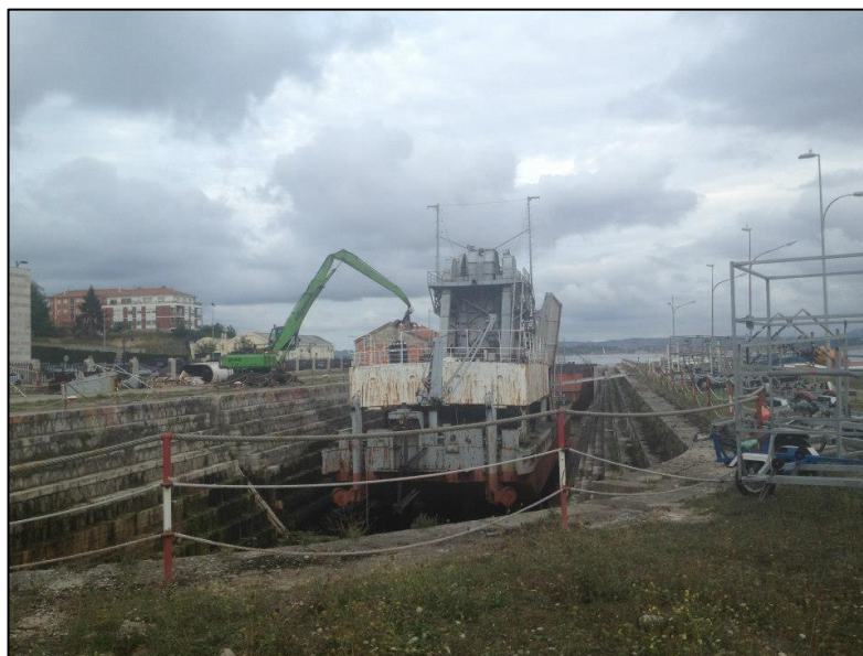
Imagen de una grúa realizando las labores del desguace de la draga.
