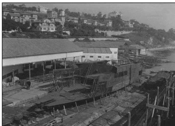
Construcción del mercante Mirenchu en las gradas de Gamazo.
