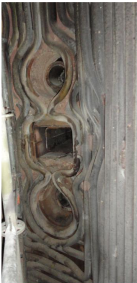
Figura 6. Quemadores de la caldera de súper presión. Superior e inferior: fueloil. Medio: carbón.
