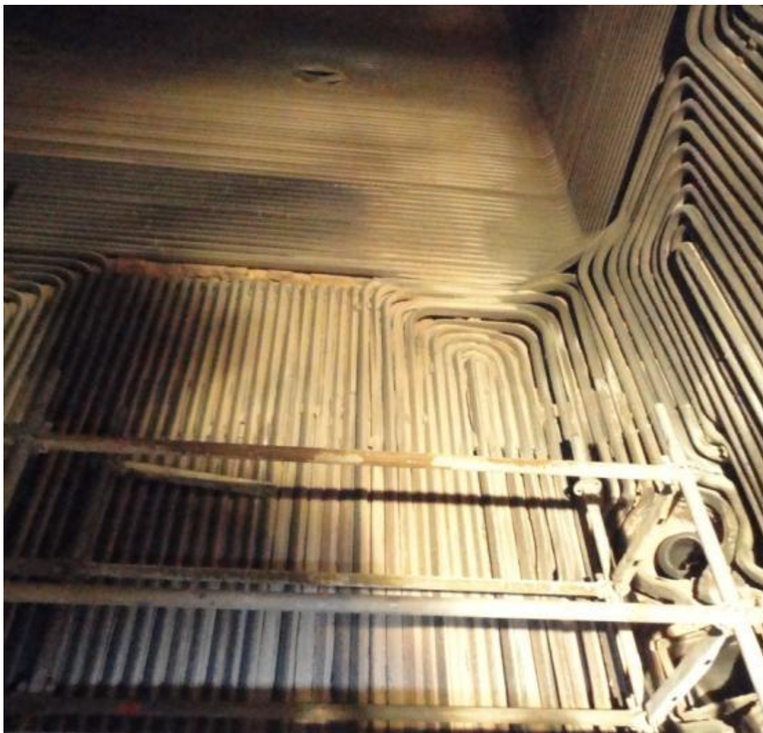
Figura 3. Hogar de la caldera de súper-presión (Caldera acuotubular).
