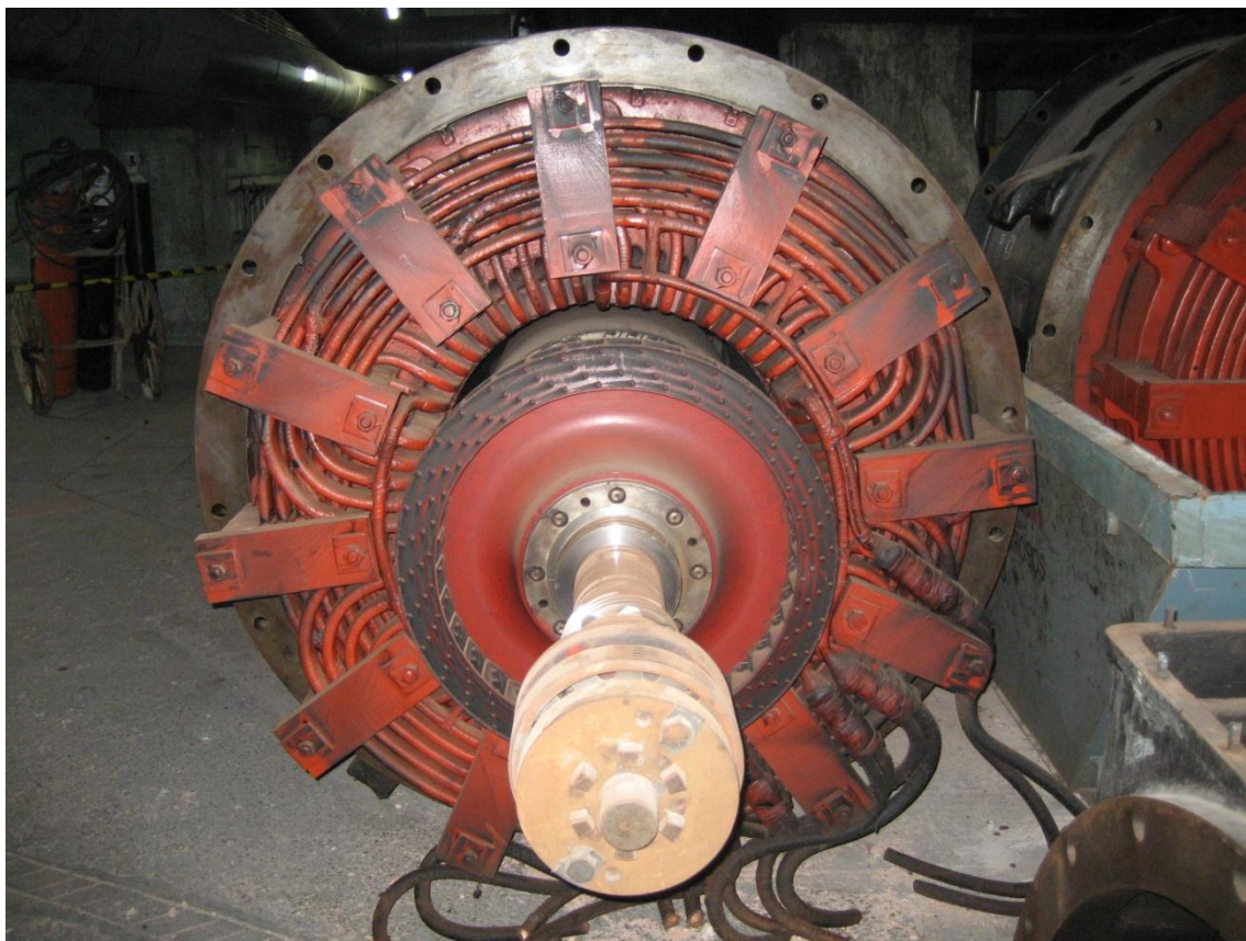
Figura 21. Alternador acoplado a la turbina de vapor.
