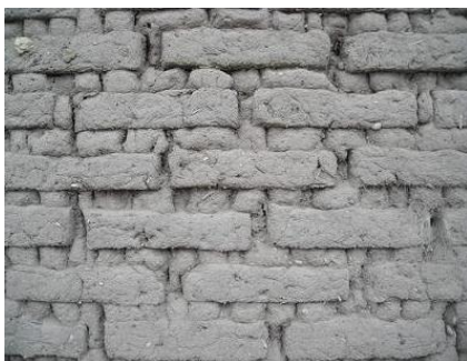
Imagen: construcción de un tabique con bloques de adobe / tierra compactada.
