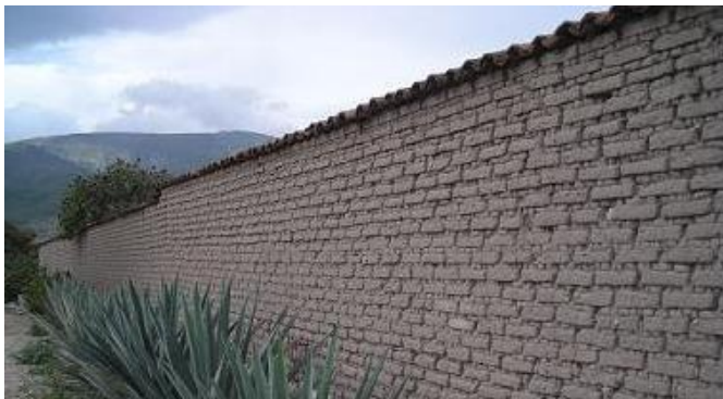
Imagen: Cerramiento de un edificio o de una parcela con bloques de tierra armada.
