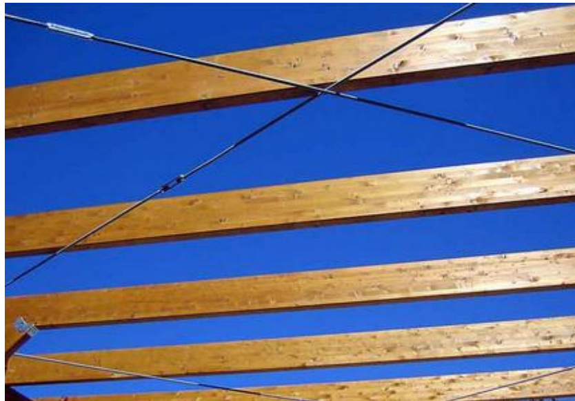
Imagen: "Cruz de San Andrés" con elementos metálicos en una estructura de madera.
