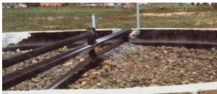
Figura 1. Imagen que ilustra el medio filtrante de un lecho bacteriano
