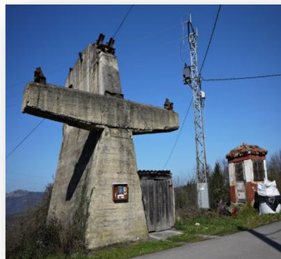
*Fig. 25: soporte del cable aéreo para transporte del carbón*
