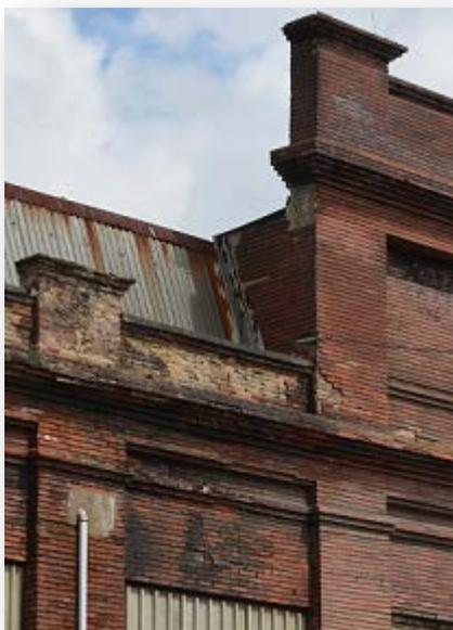
*Fig. 31: La plaqueta de ladrillo se conserva en mal estado. Colección propia (2015)*
