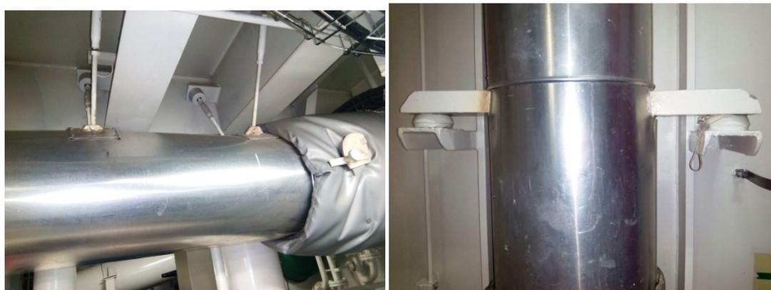
Figura 30 - Refuerzos horizontales y vertical en la chimenea
