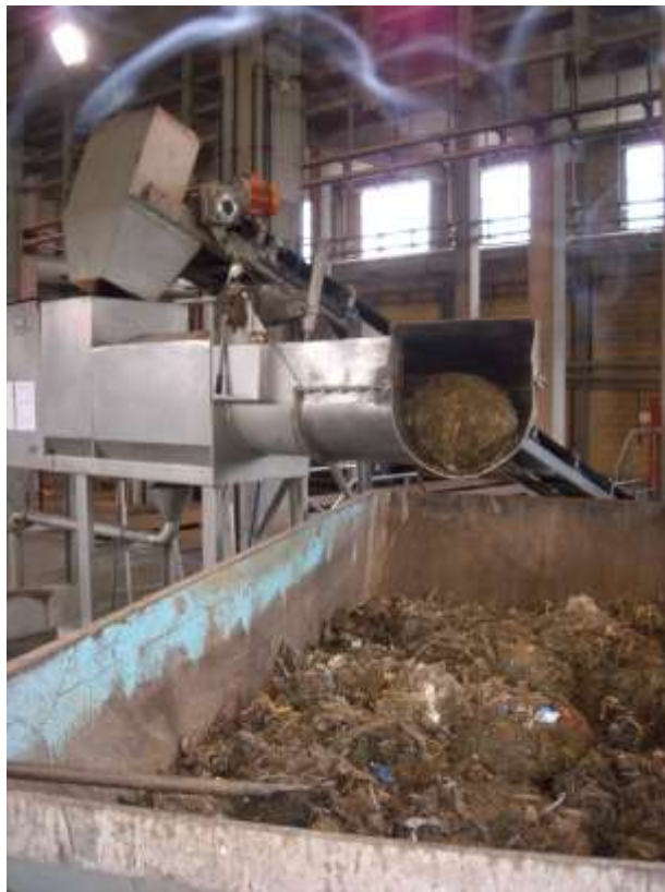
Figura 7.4. Residuos resultantes de la depuración de aguas. (JORA 2011).
