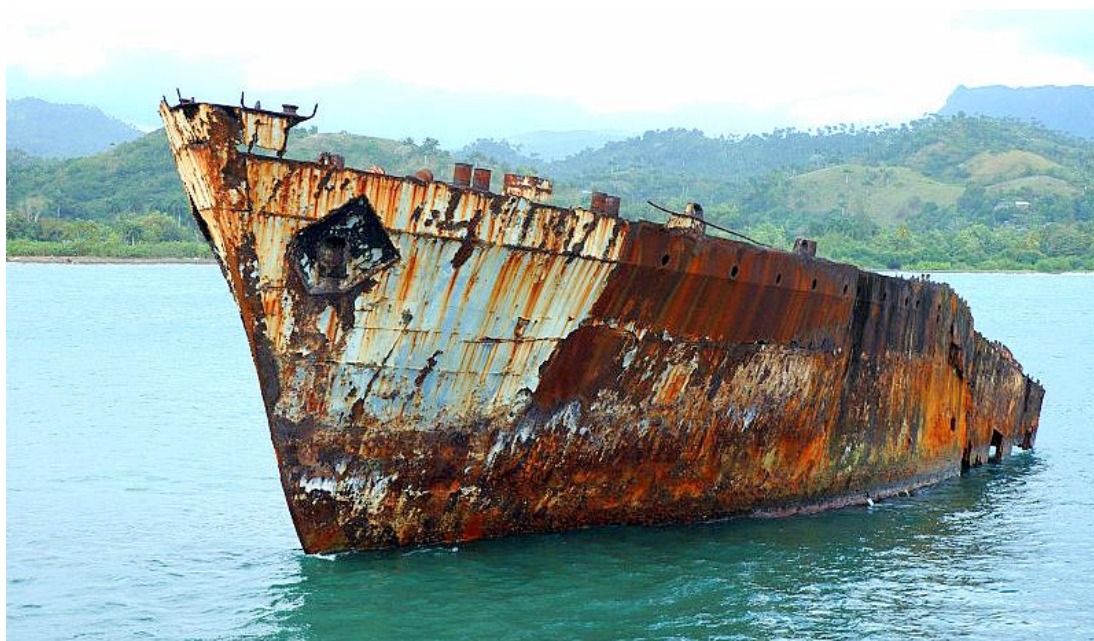
Figura 52. Casco de un buque con corrosión generalizada
