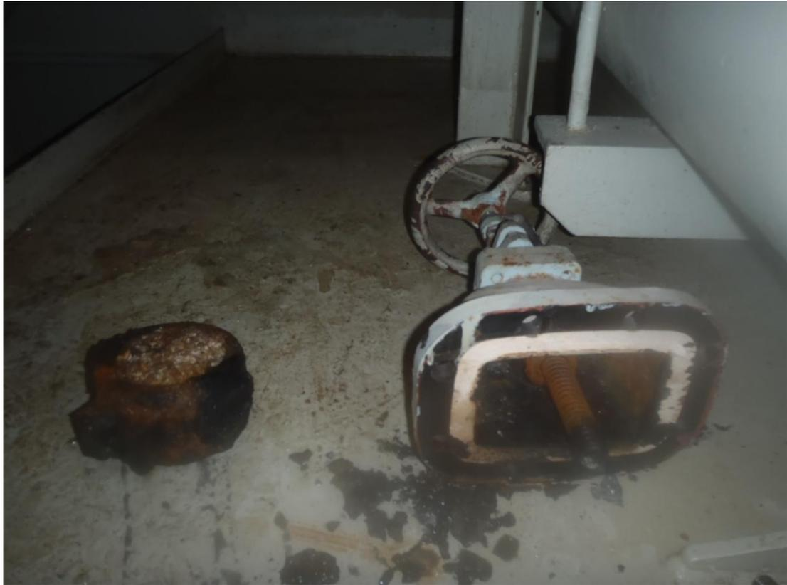
**Ilustración 13--Corrosión en válvulas, tuberías y tanques**
