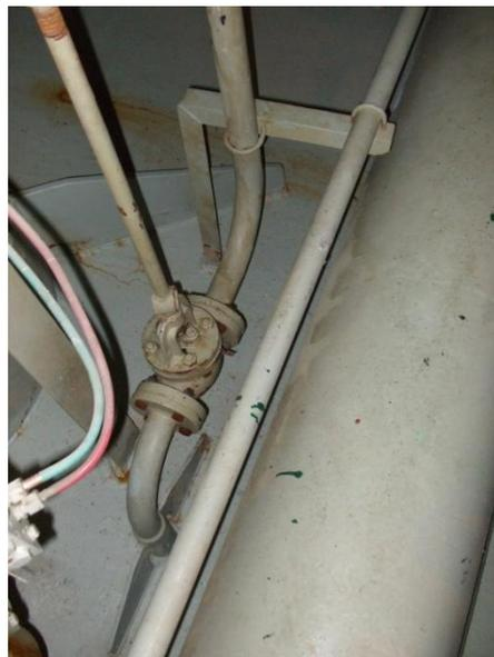
**Ilustración 37-Inyeccion toma de mar baja babor**
