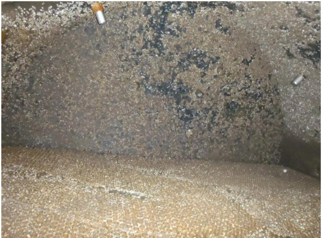
**Ilustración 14- Incrustaciones en el condensador principal**
