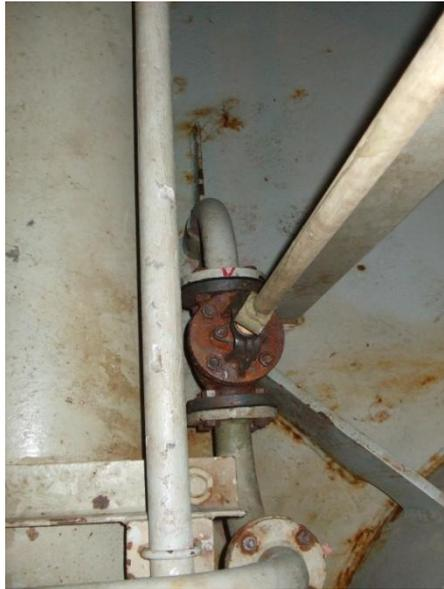
**Ilustración 36-Inyeccion toma de mar baja estribor**
