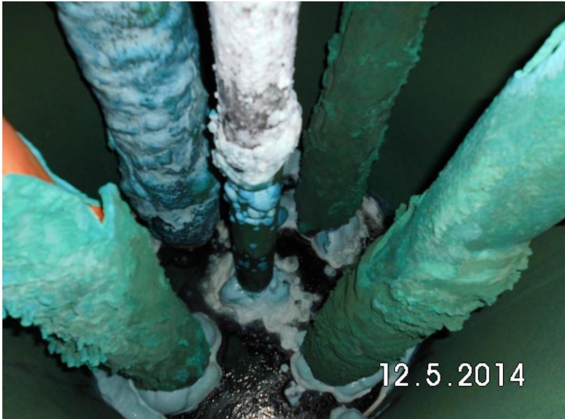
**Ilustración 11-Depósitos de cobre en los tanques**
