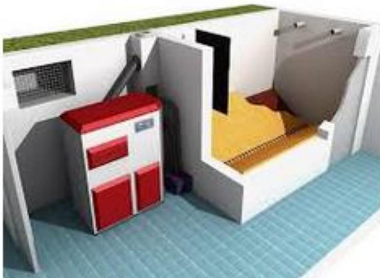
*Ilustración 20.- De obra, con dos suelos inclinados*
