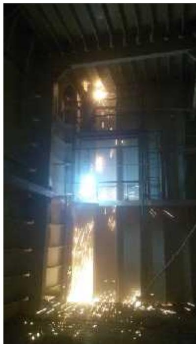
IMAGEN 35: Soldadura en un tanque de lastre del Buque CAP Finistere. Elaboración propia.
