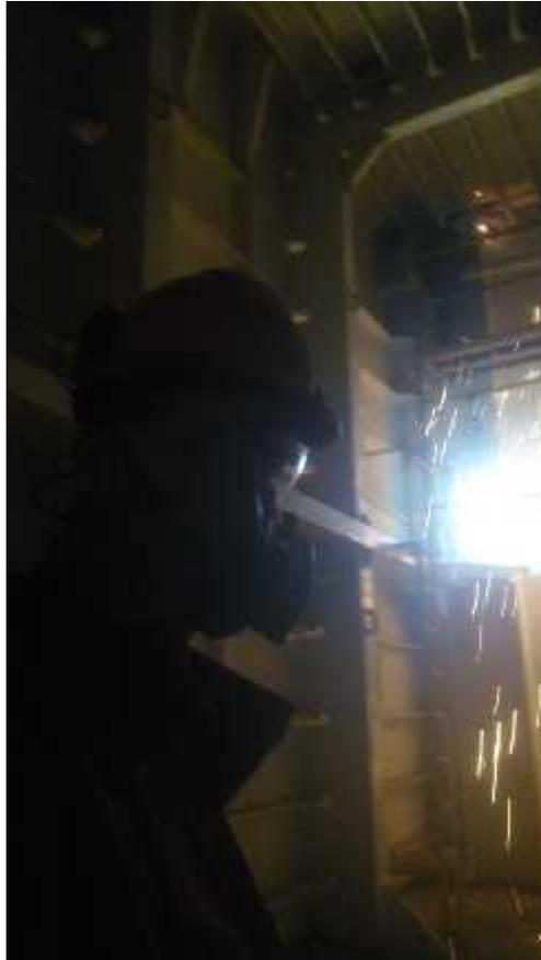
IMAGEN 29: Recurso preventivo vigilando trabajos de soldadura en tanque del buque CAP Finistere. Elaboración propia.
