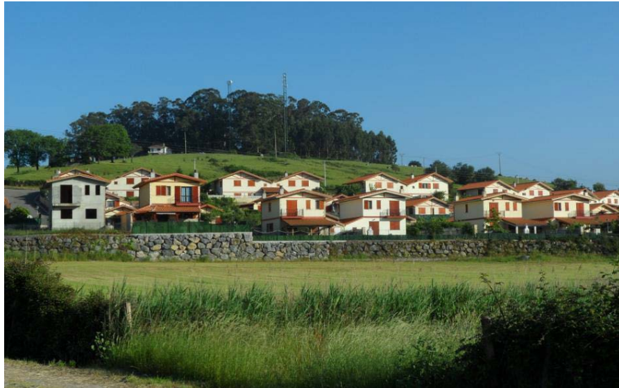
Figura 4. Viviendas construidas ilegalmente en suelo incluido en el PORN de las Marismas de Santoña, Victoria y Joyel (urbanización La Llama, Argoños).
