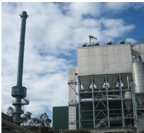
***Figura 18. Sistema de depuración de gases de la planta integral de gestión de RSU de Cantabria.***
