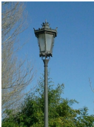
Luminaria en perfectas condiciones
