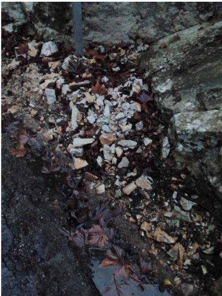
imagen 20- depósitos de rocas a pie del talud
