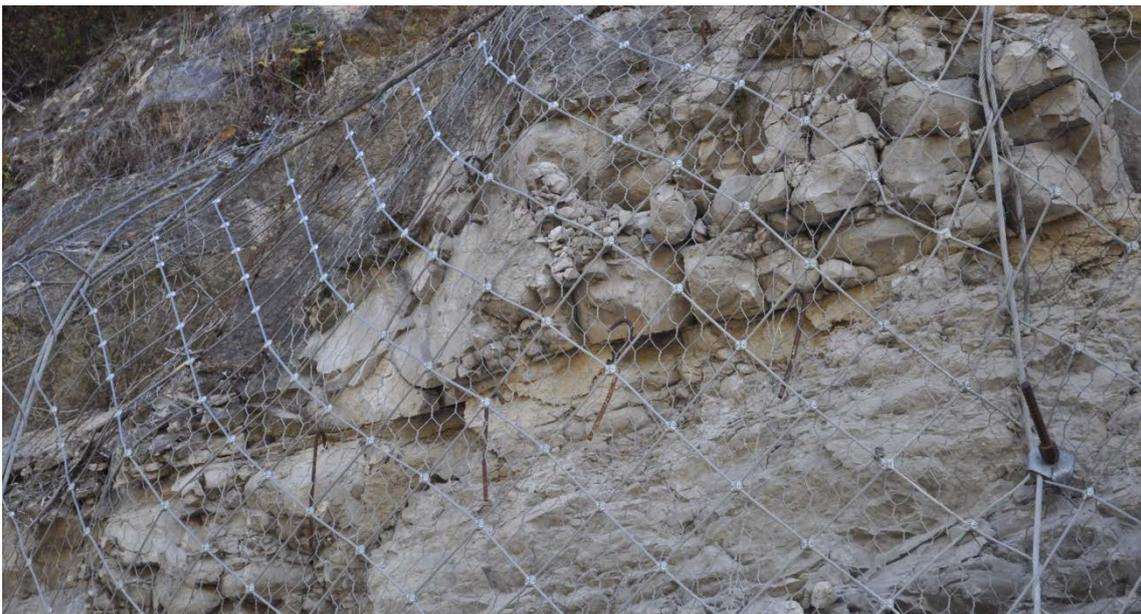
Imagen 5- Red de cables combinada con malla de triple torsión
