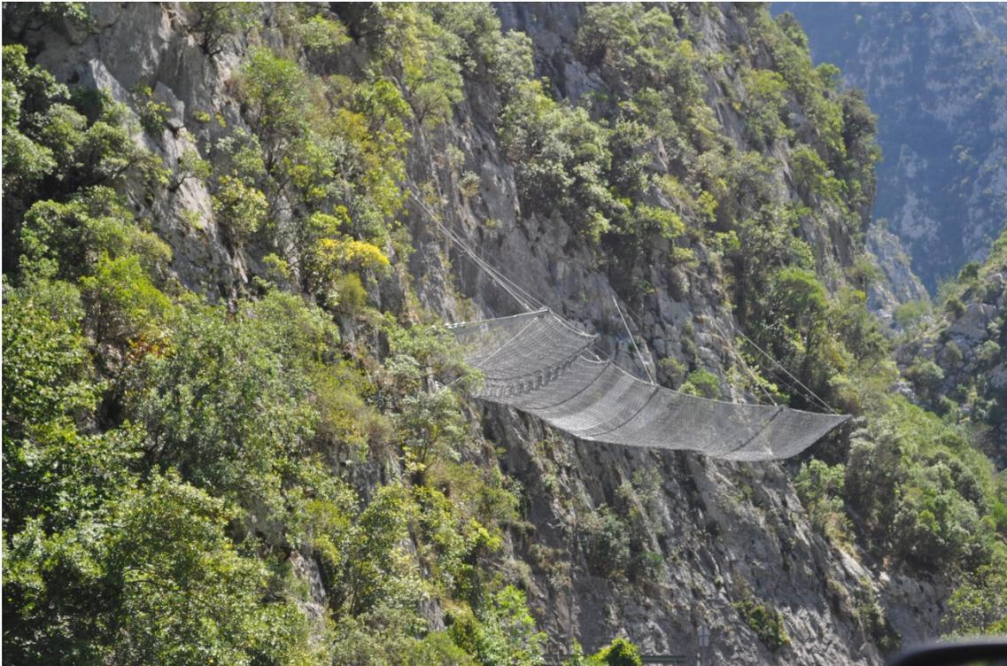
Imagen 7-Pantalla dinámica en galería colocada sobre un talud vertical en el desfiladero
