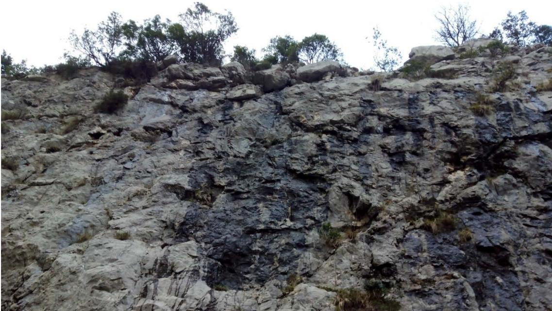
Imagen 35- Rocas inestables en el talud del punto 18
