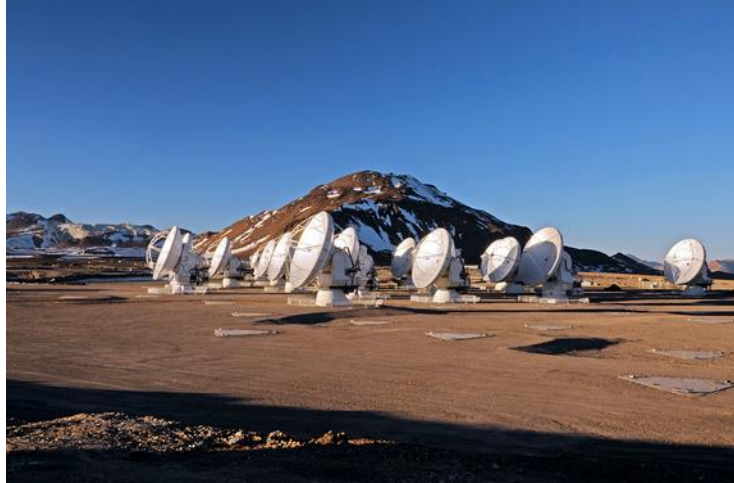
Figura (1.7). "Atacama Large Millimeter Array", 66 reflectores parabólicos de 7 m y 12 m de diámetro destinados a observar longitudes de onda milimétricas y submilimétricas
