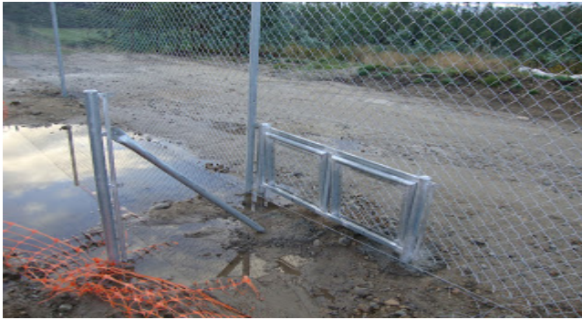
Ilustración 13 Puerta articulada para el escape de mamíferos de tamaño mediano. (8)
