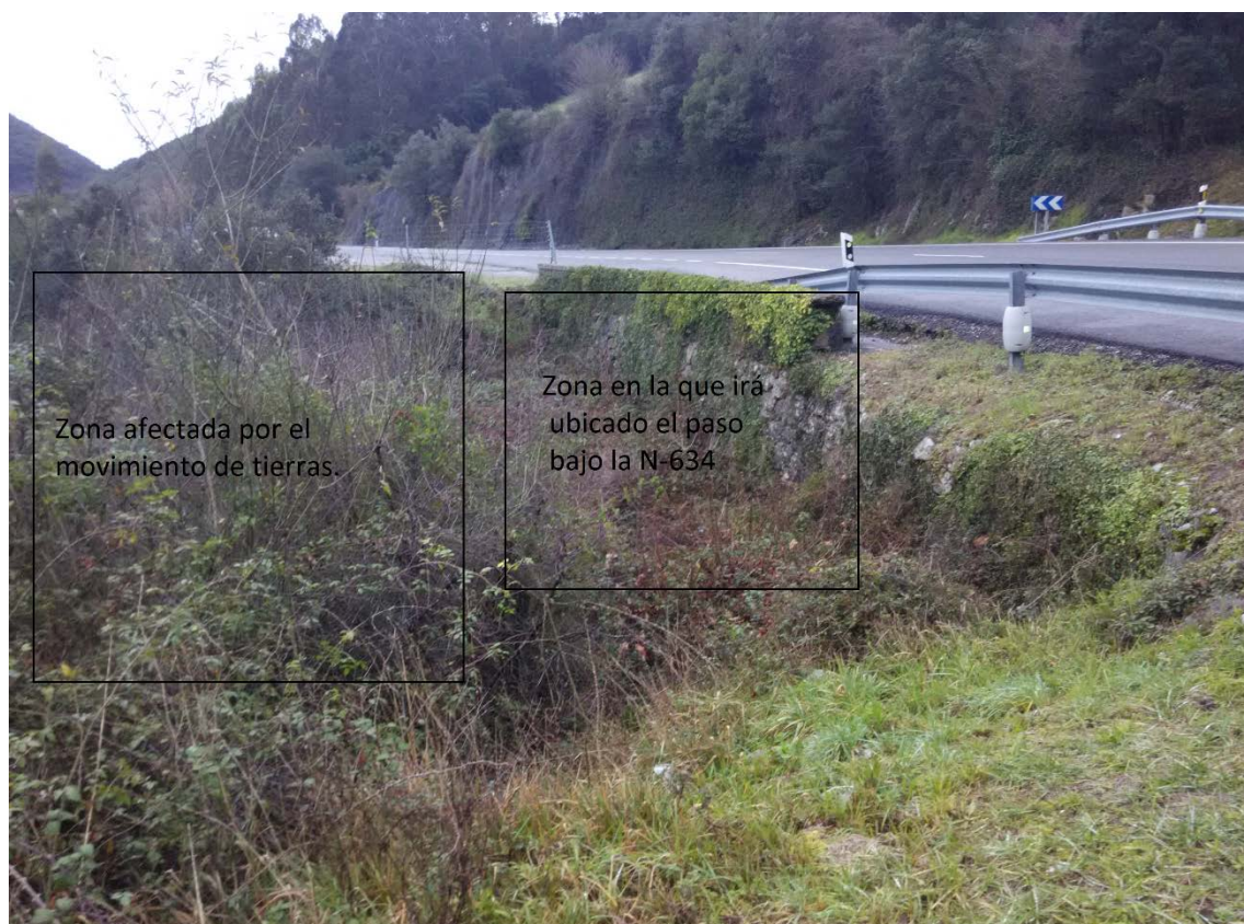
Ilustración 142 Fotografía en la que se puede apreciar la cara sur del paso inferior bajo la N-634 y parte de la zona afectada por el movimiento de tierras.
