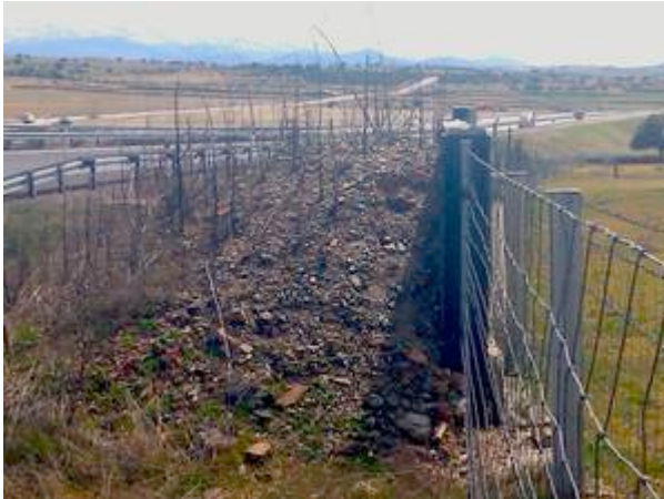
Ilustración 11 Una rampa de salida construida con tierra, en la misma zona, puede ser utilizada por distintas especies. (7)
