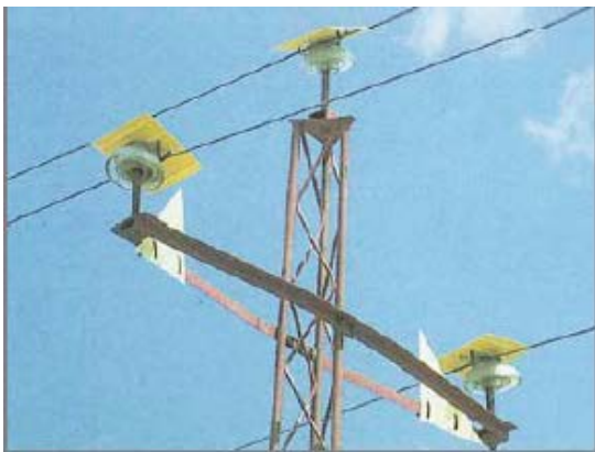
Ilustración 73 - Placa aislante encima del aislador. (16)
