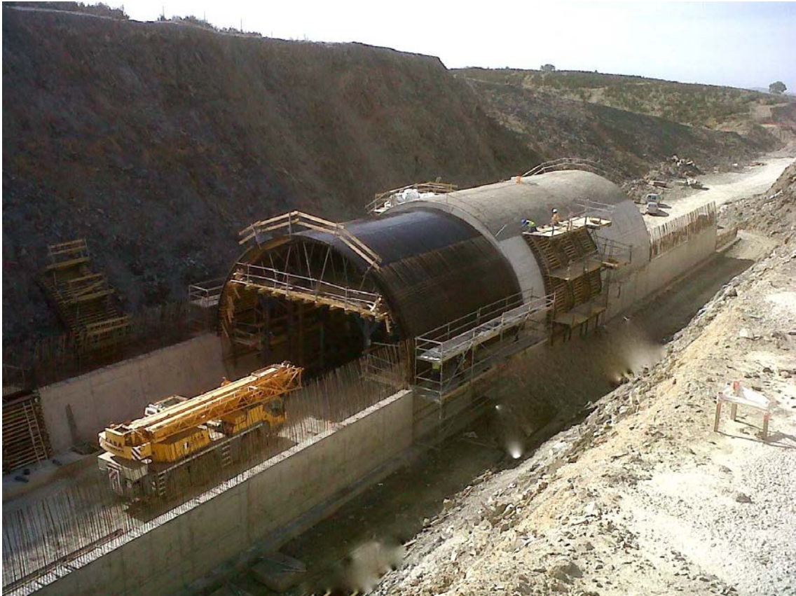
Ilustración 42 Paso de vehículos por el interior de la estructura durante el momento de construcción en Casas de Millán-Cañaveral, Cáceres. (10)
