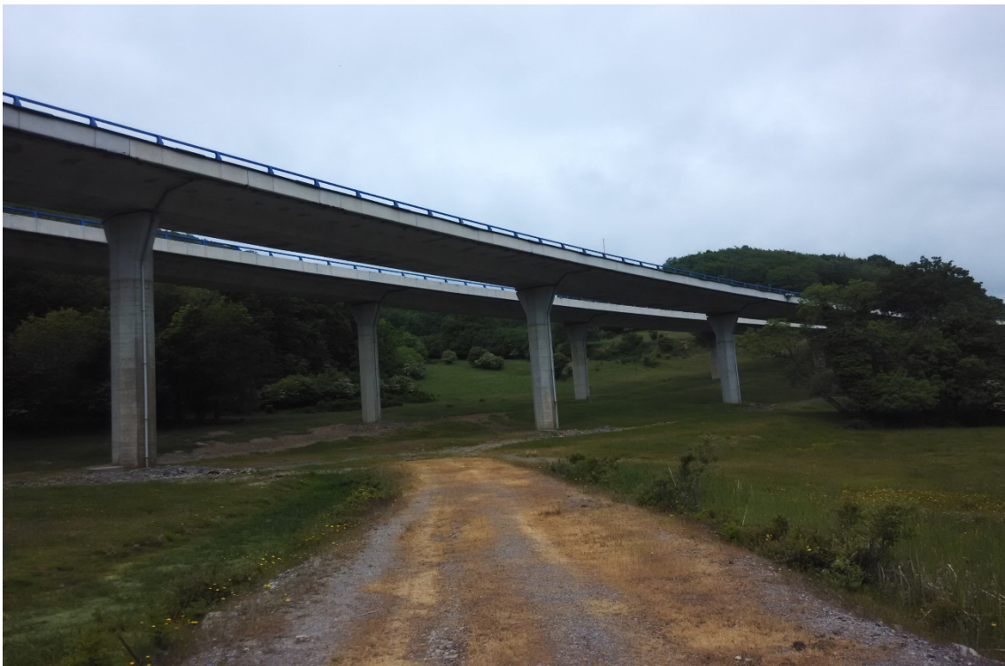
Ilustración 150 Vista de la zona del viaducto de la A-8 en la que se puede apreciar el espacio que tienen los animales para pasar por esta zona.
