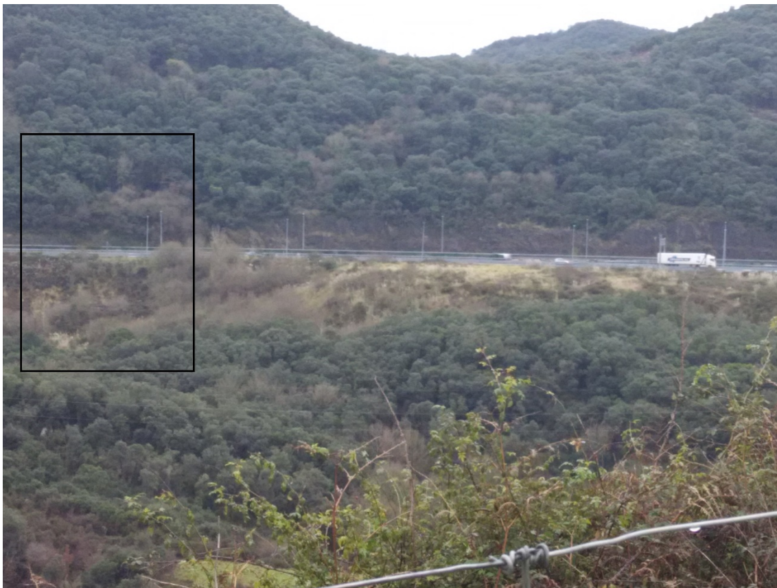
Ilustración 138 Foto tomada desde la N-634 en la que se puede apreciar la A-8 y la zona donde ira ubicado el paso superior.
