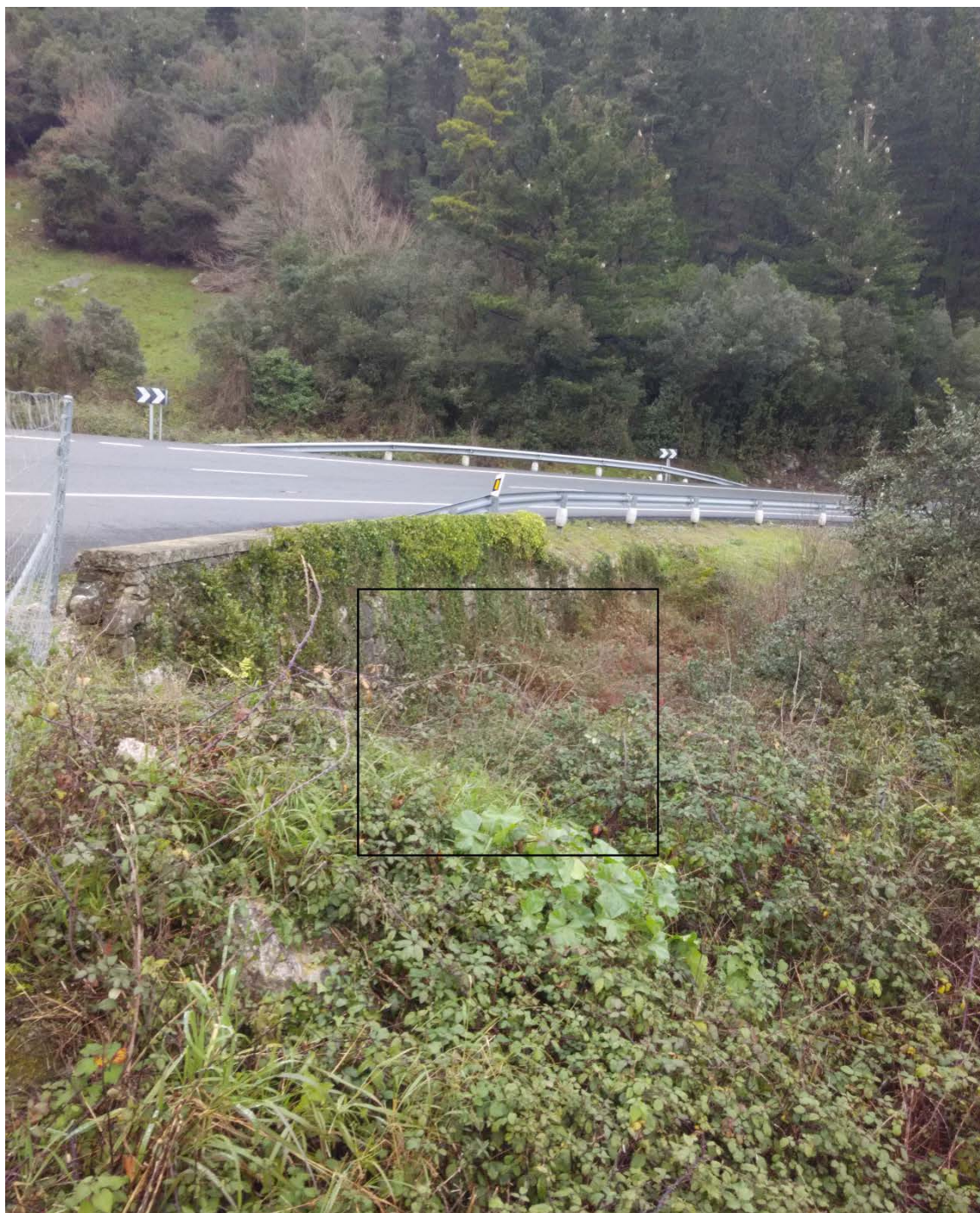
Ilustración 140 Fotografía tomada desde la N-634 en la que se puede apreciar donde ira colocada la zona sur del paso inferior bajo la propia N-634
