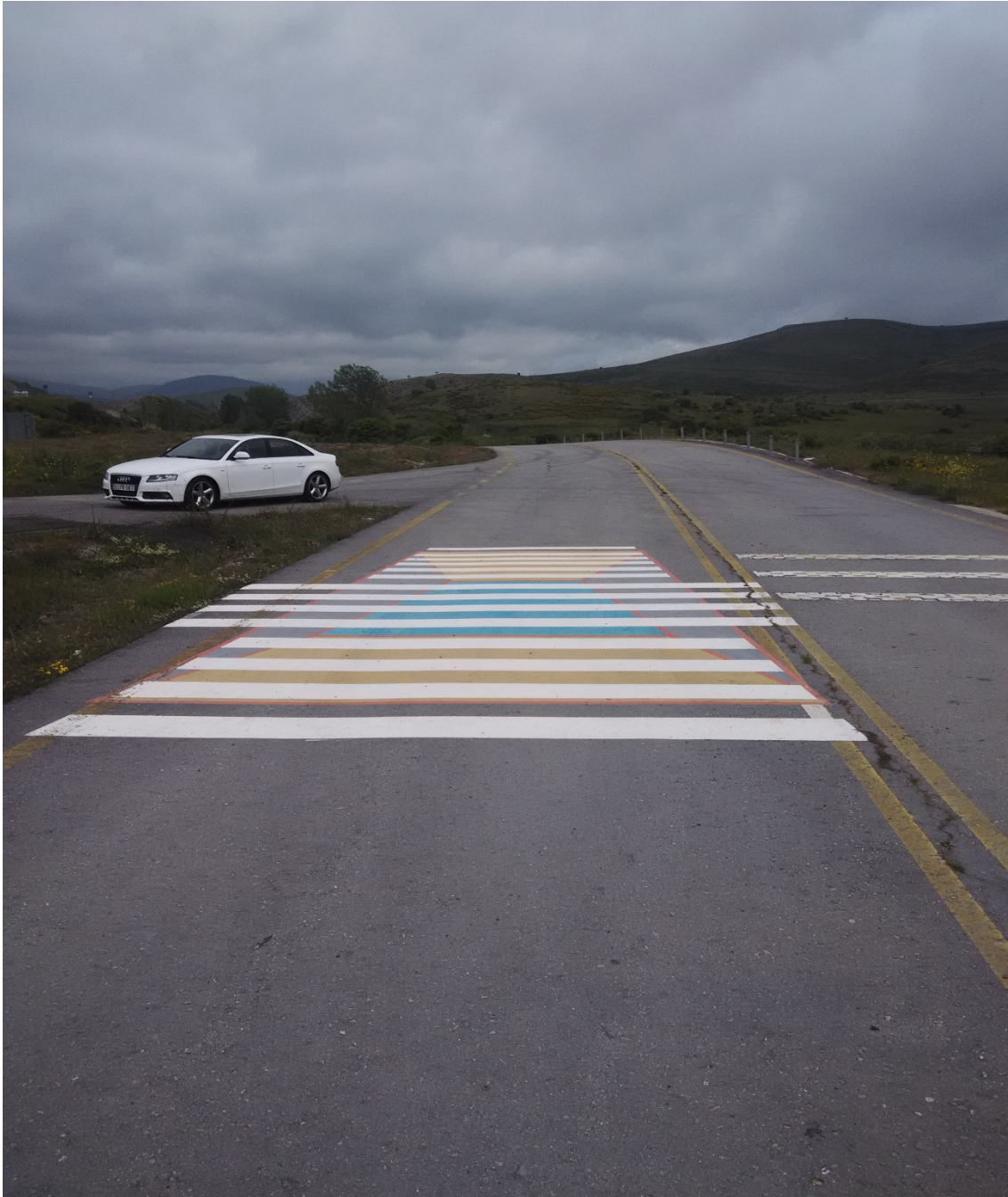
Ilustración 64 Prueba de un paso canadiense pintado en la una carretera fuera de servicio cerca de la población de Fombellida.
