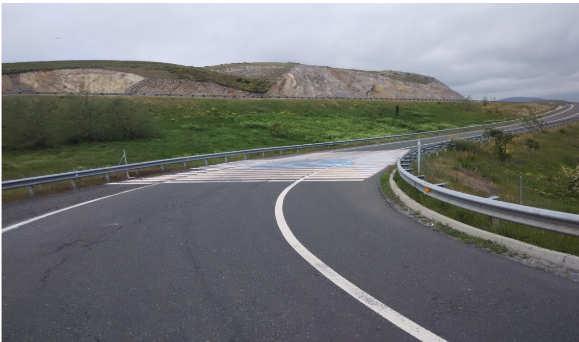
Ilustración 66 Paso canadiense pintado en uno de los accesos de la A-8 cerca de Fombellida (Cantabria). Como se puede apreciar el vallado perimetral llega justo hasta el comienzo de la carretera, lo que provoca que el animal lo perciba como un embudo y no atraviese el paso.
