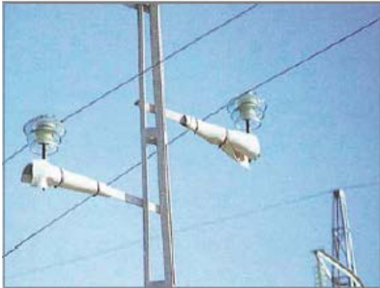
Ilustración 74 - Manta aislante cubriendo la cruceta. (16)
