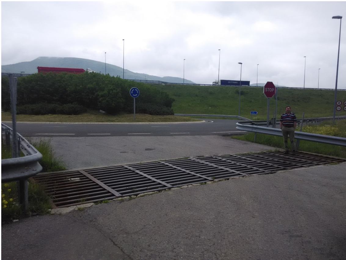
Ilustración 63 Paso canadiense ubicado en uno de los accesos de la A-8 cerca de la población cántabra de Mataporquera.
