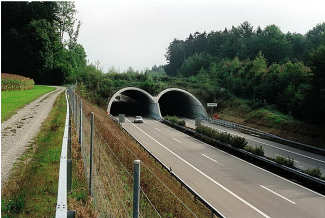
Ilustración 41 Vista de un paso de fauna construido con el sistema falso túnel convencional. (9)
