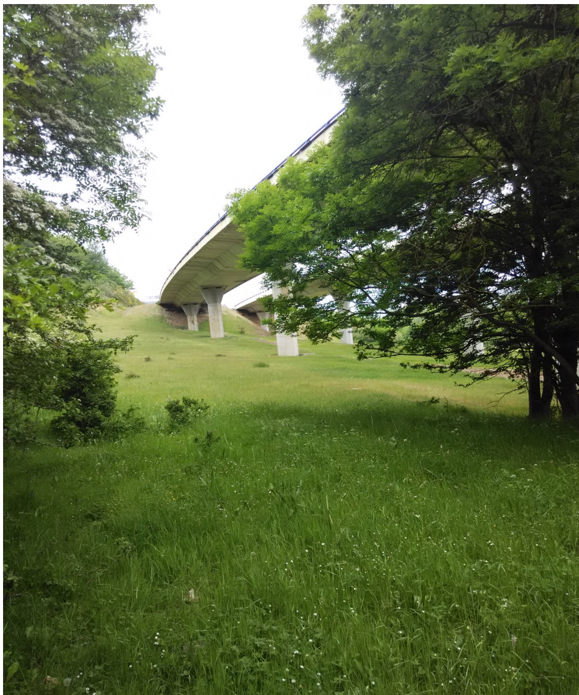
Ilustración 152 Zona del paso de los animales bajo el viaducto de la A-8.
