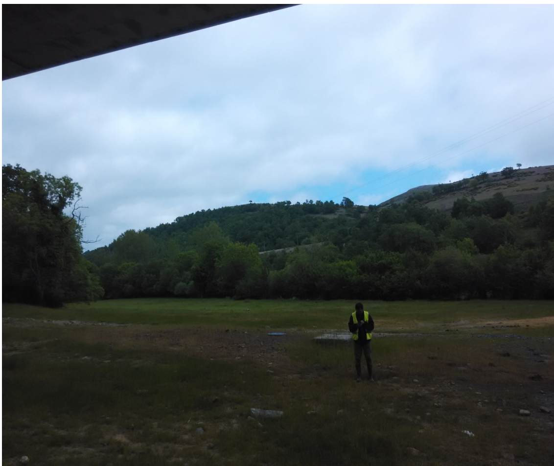
Ilustración 151 Vista desde debajo de la A-8 de la zona donde se encuentran la N-611, en la que se puede apreciar la existencia de vegetación.
