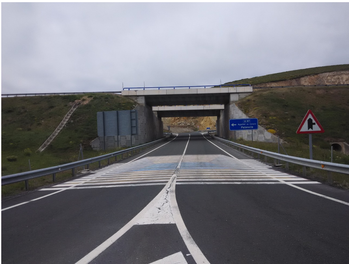
Ilustración 67 Paso canadiense pintado en uno de los accesos de la A-8 cerca de Fombellida (Cantabria).
