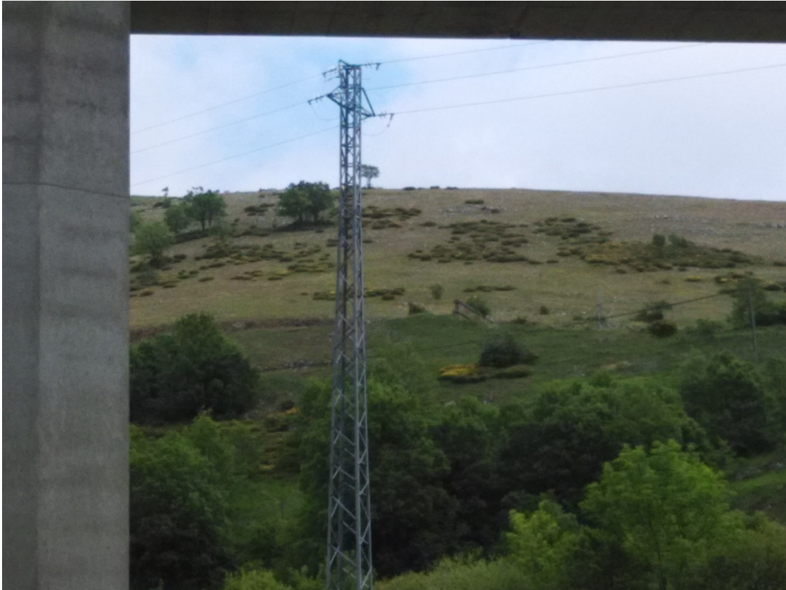
Ilustración 155 Vista del paso superior sobre la línea de ferrocarril Palencia-Santander
