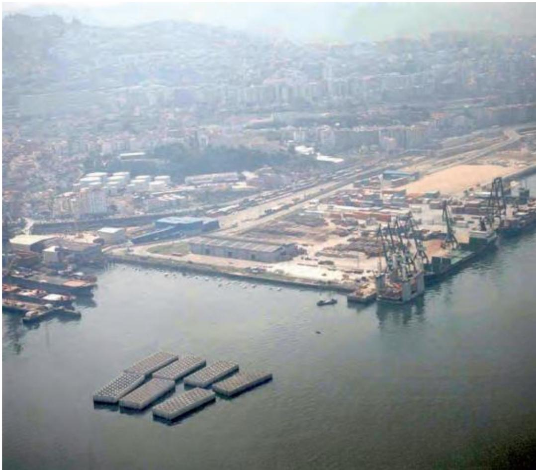
Figura 4-9: Cajones prefabricados de hormigón armado fondeados provisionalmente
