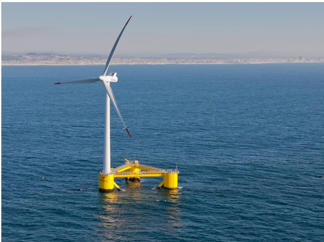
**Figura 2-28: Instalación flotante Windfloat, cerca de la costa portuguesa**
