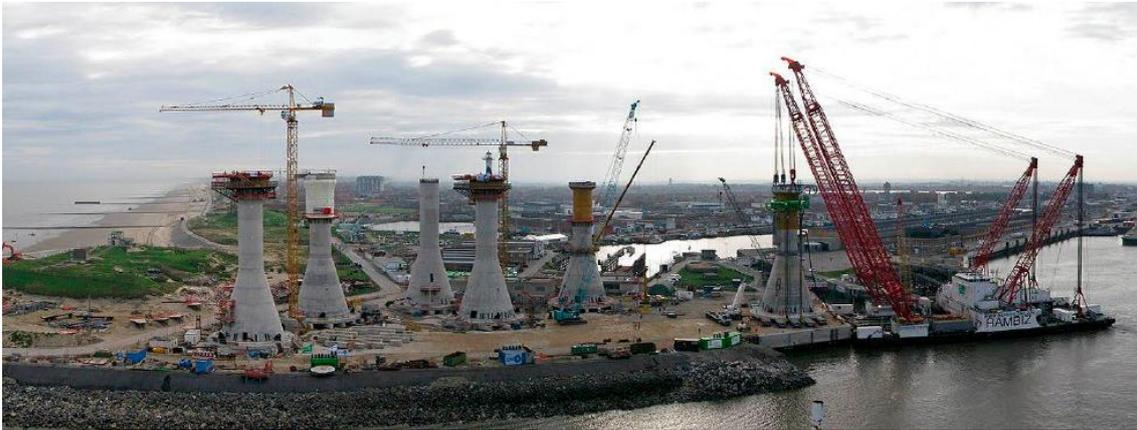
**2-45: Embarcación RAMBIZ botando una estructura de gravedad**
