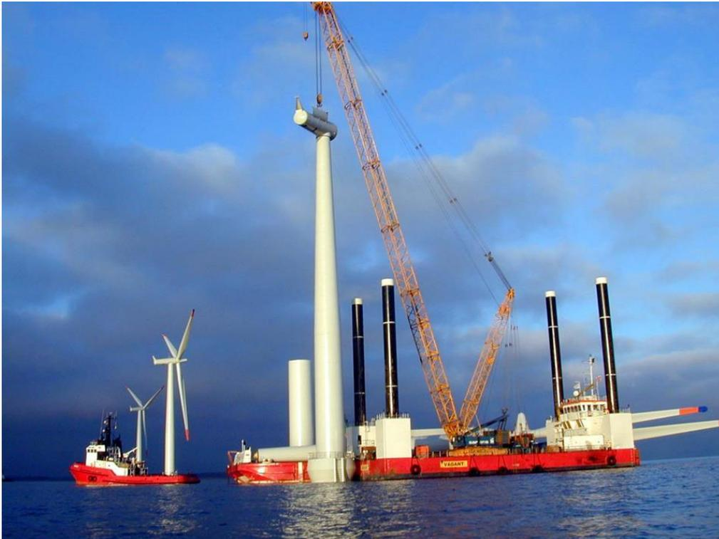
Figura 2-9: Instalación de un aerogenerador en un parque eólico offshore
