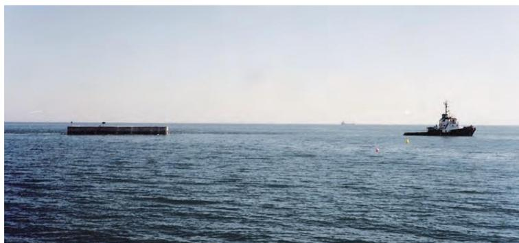
Figura 4-16: Remolque de cajón prefabricado de hormigón armado
