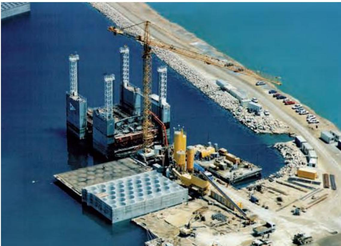
Figura 4-6: Fabricación de cajones rectangulares con celdas circulares mediante dique flotante
