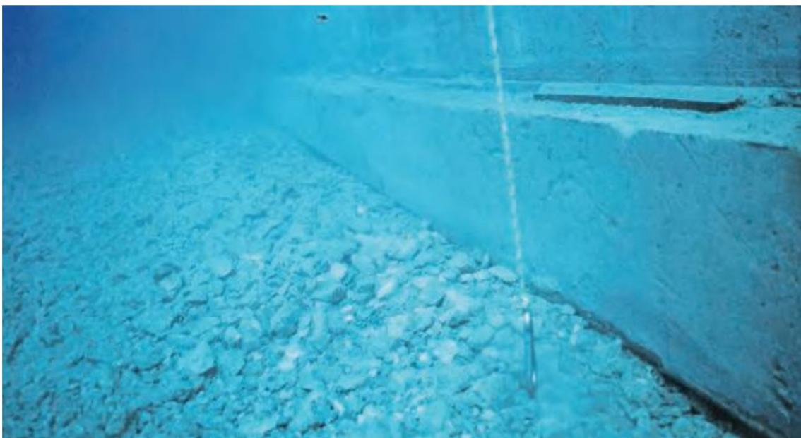
Figura 4-48: Comprobación del enrase tras fondeo de un cajón
