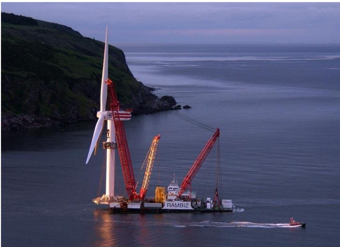
Figura 4-50: Transporte de aerogenerador offshore mediante grúa RAMBIZ
