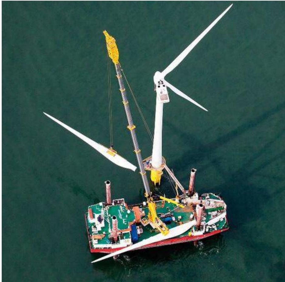
**4-19: Grúa de 1.200 t sobre barcaza auto-elevable para instalación de estructuras offshore**
