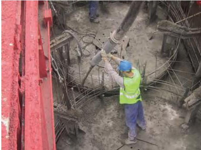
**Figura 4-13: Hormigonado de un cajón**
