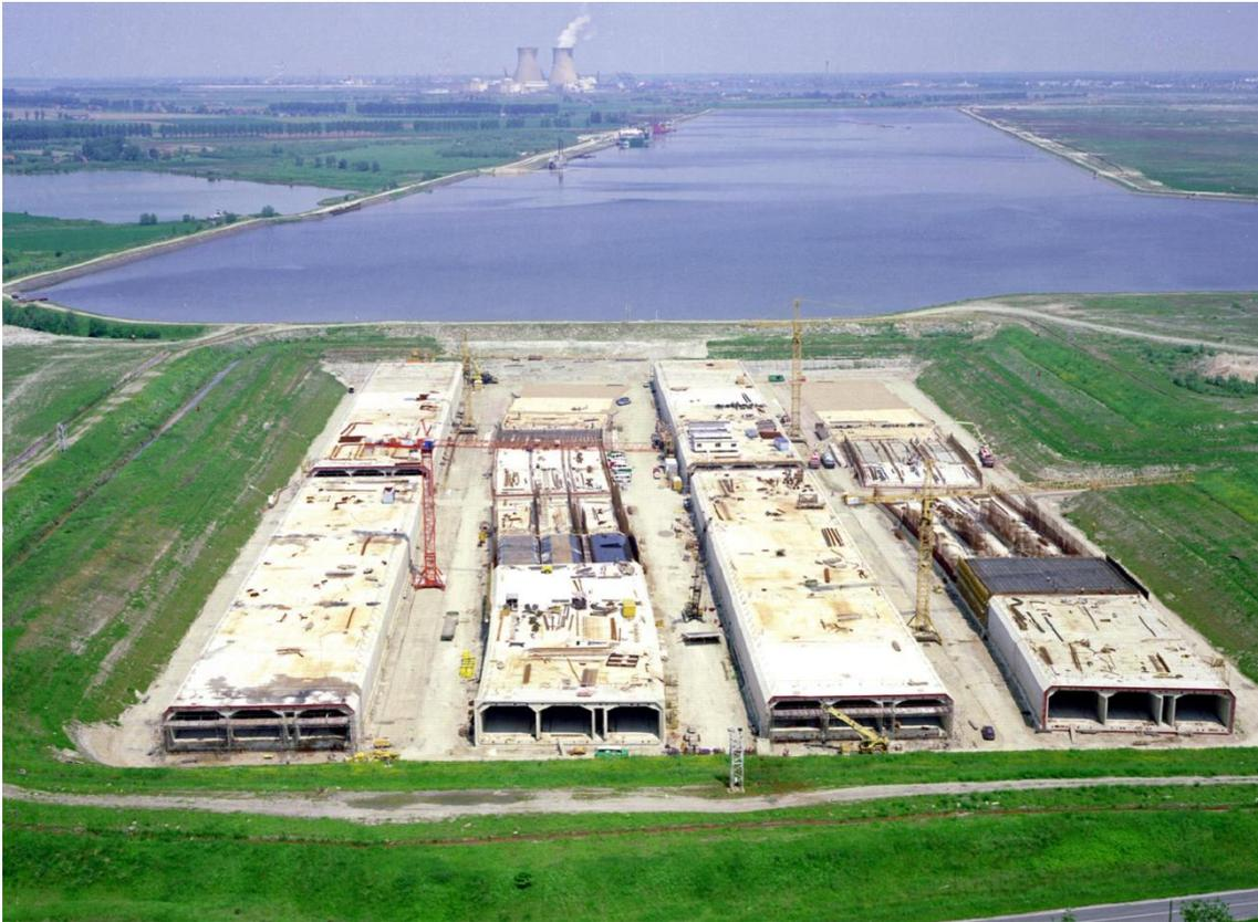
4-53: Parque de fabricación de secciones de túnel de hormigón armado
