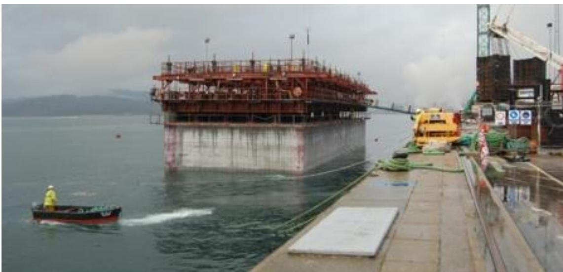
Figura 4-11: Cajones flotantes de hormigón en Marín (Pontevedra), ejecutados por Sacyr
