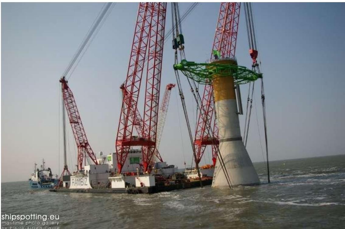
Figura 4-49: Grúa RAMBIZ transportando una cimentación en gravedad
