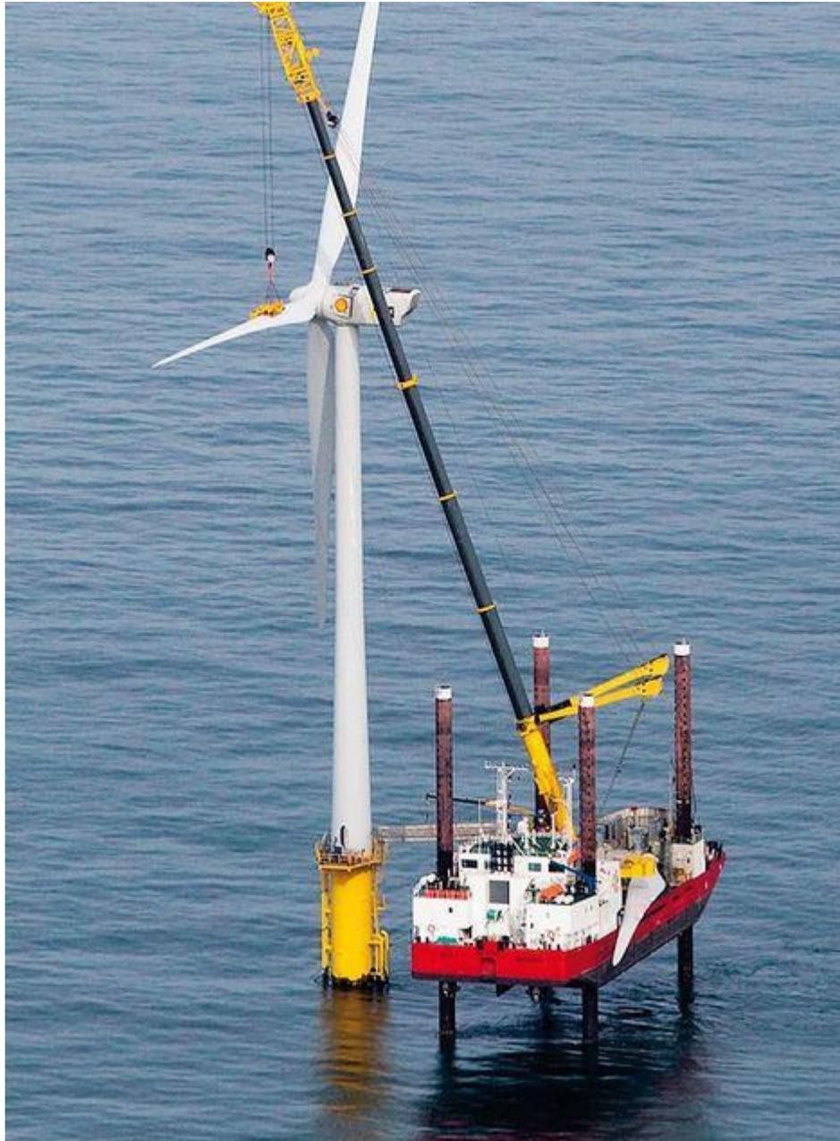
**4-20: Instalación de aerogenerador offshore mediante grúa telescópica montada sobre barcaza auto-elevable**
