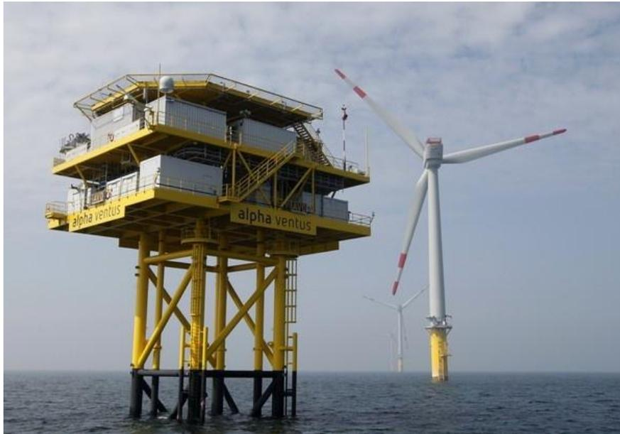
Figura 2-2: Plataforma de subestación offshore
