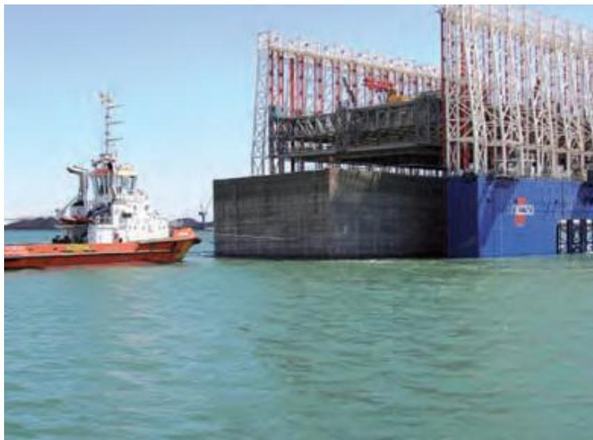
Figura 4-15: Operación de botadura de un cajón de hormigón armado construido en dique flotante
