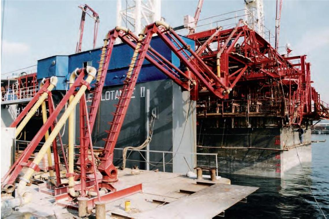
Figura 4-10: Equipos de bombeo de un dique flotante
