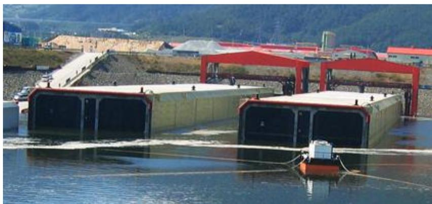
4-52: Remolque de secciones prefabricadas de un túnel sumergido
