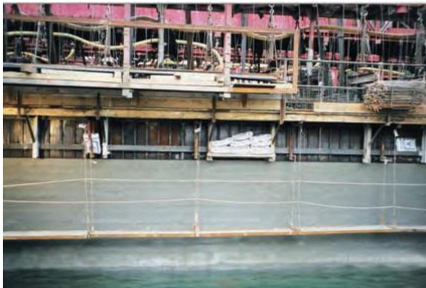
Figura 4-12: Protección de los paramentos externos del cajón
