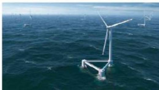
Figura 2-20: Plataforma semi-sumergible Windfloat
