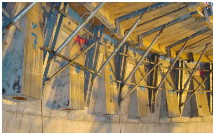
2-43: Anclajes de pretensado en el interior de la estructura
