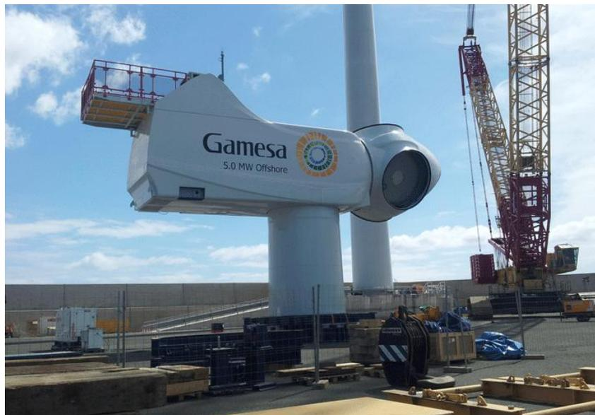
Figura 2-16: Montaje de la nacelle del aerogenerador de Arinaga previa a su instalación en la torre
