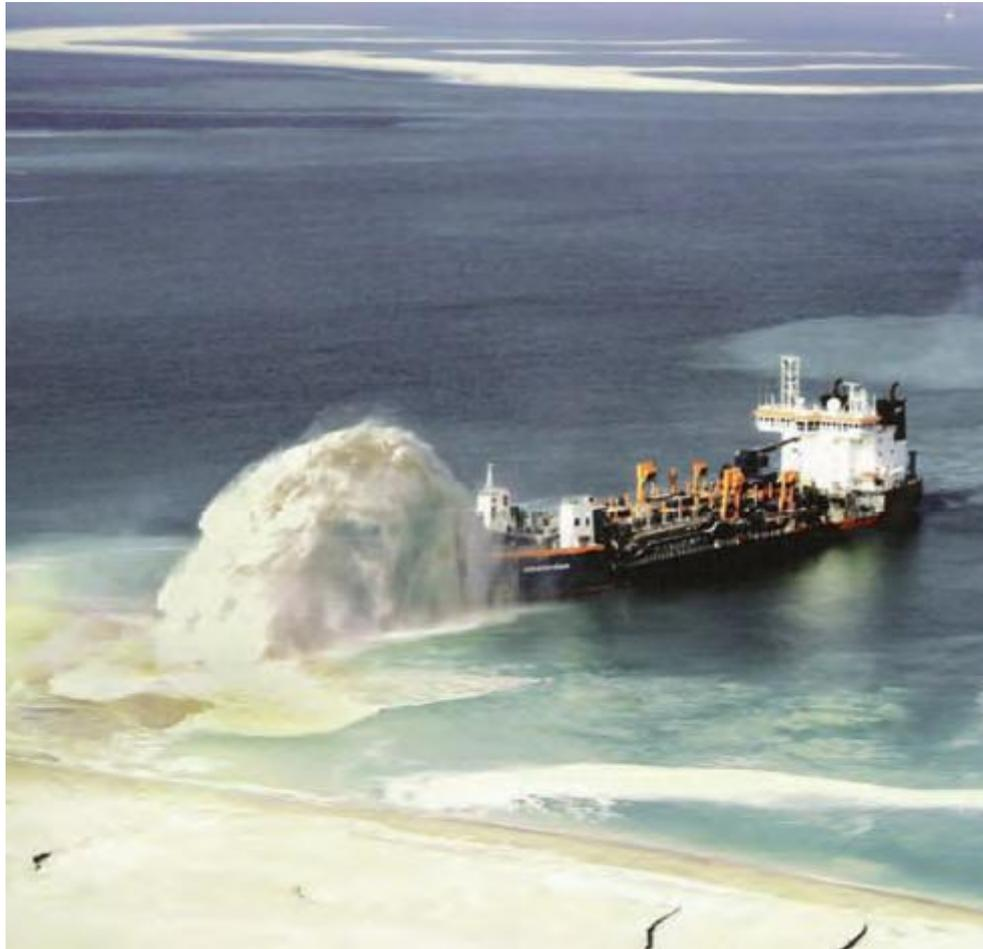
Figura 4-37: Dragas de succión vertiendo el material proyectándolo mediante un cañón (*rainflow*)
