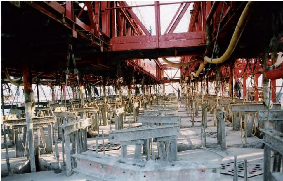
**Figura 4-4: Equipos de encofrado de un dique flotante**
