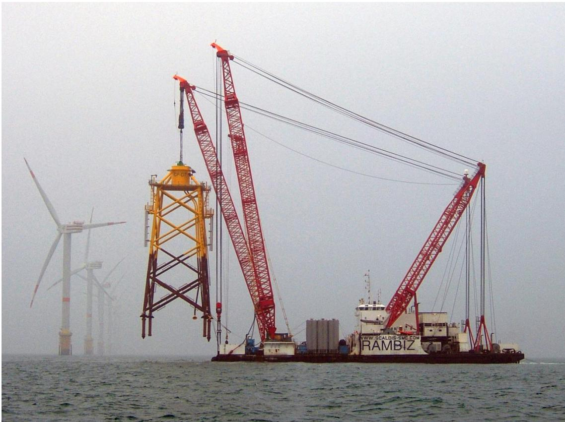
4-17: Grúa RAMBIZ transportando una estructura *jacket* para eólica offshore
