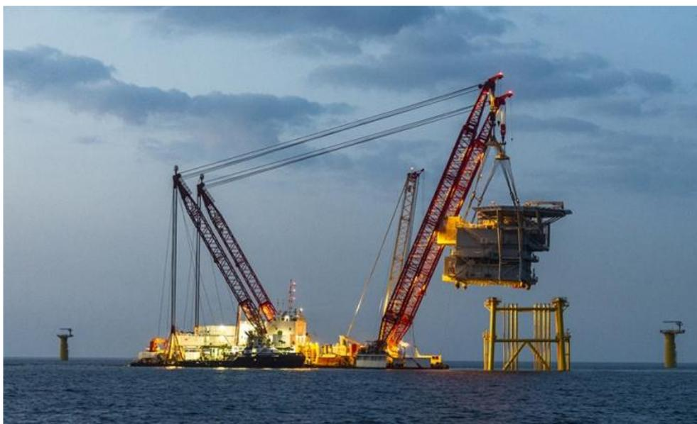
Figura 2-10: Instalación de plataforma de la subestación de un parque eólico offshore
