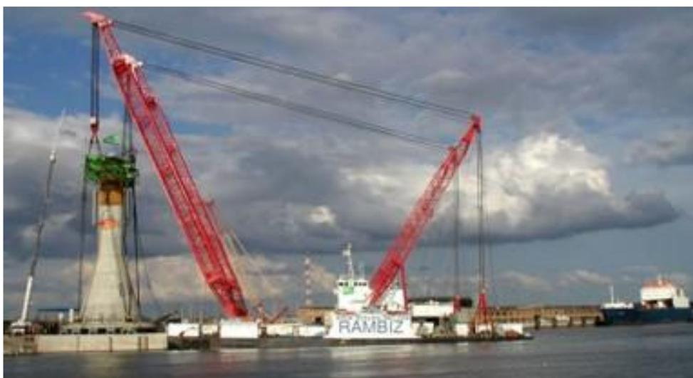
5.1.3-2: Izado de estructura de gravedad offshore para su traslado y fondeo mediante grúa RAMBIZ
