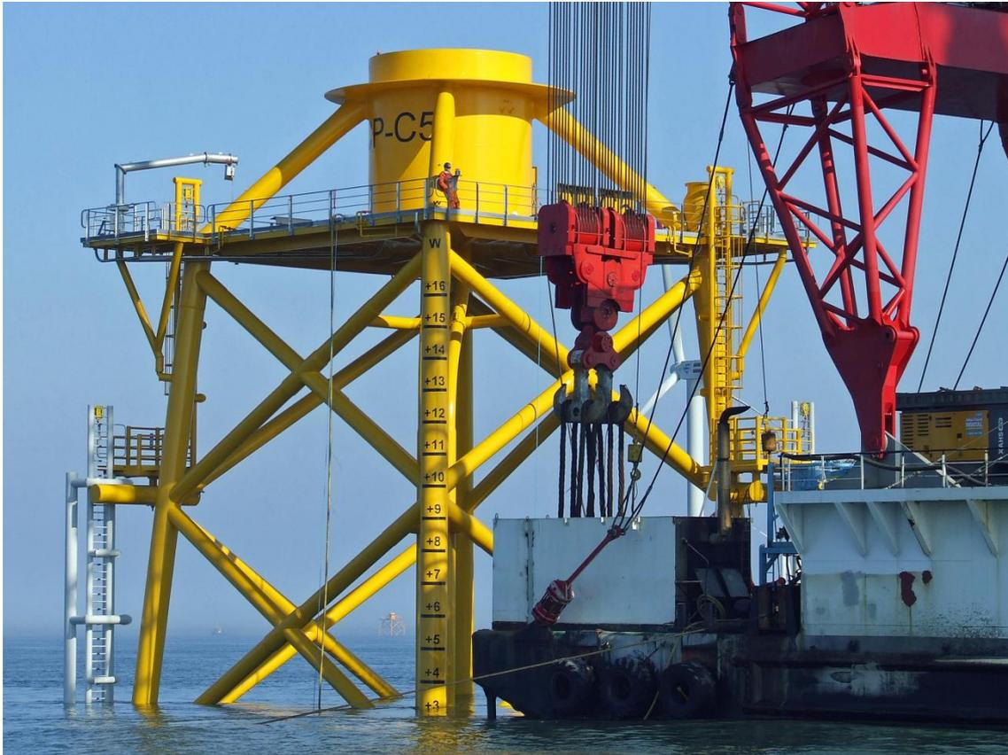
4-18: Instalación de estructura *jacket* mediante grúa RAMBIZ
