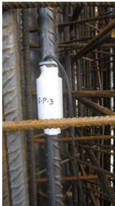
*Figura 0- 3 Barra Instrumentada en una de las fases de construcción del arco del Viaducto del Tajo*
