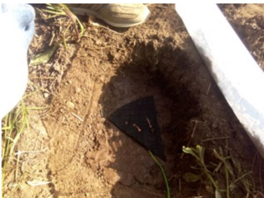
*Figura14: Installazione dell'anodo*
