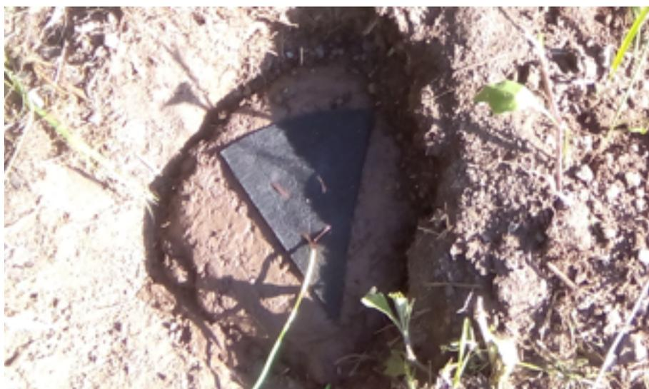
*Figura 16: Installazione del catodo*
