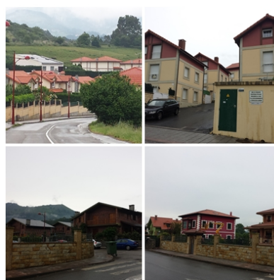
Fig. 15: Nuevas construcciones a lo largo de la carretera principal de Ampuero
