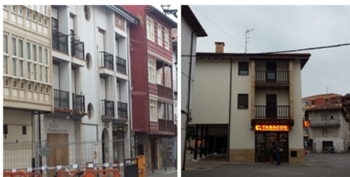
Fig. 16: Edificios renovados en el casco histórico de Ampuero
