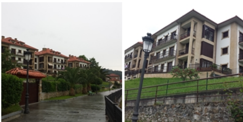
Fig. 17: Nuevas construcciones en la margen derecha de la ría de Limpias
