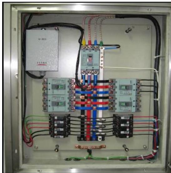
Figura 2.14 Ejemplo de conexión de ULTRA en una instalación genérica.
