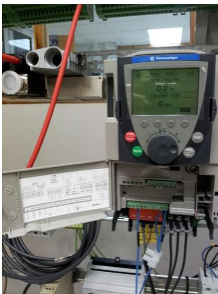
**Figura 3.2** El variador de velocidad Altivar 71 una vez incorporado al montaje de la bancada.
